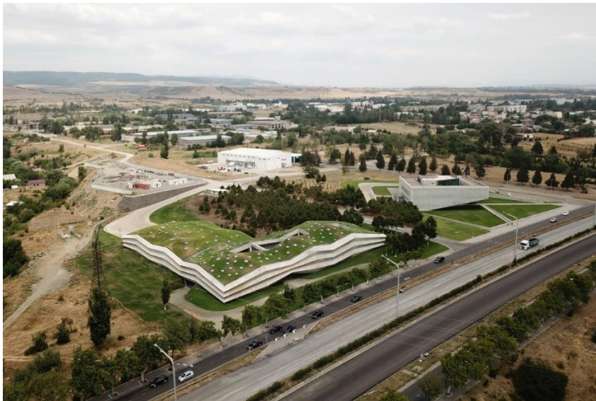
Figura 12: Vista panorámica de la Planta de Procesamiento de café
