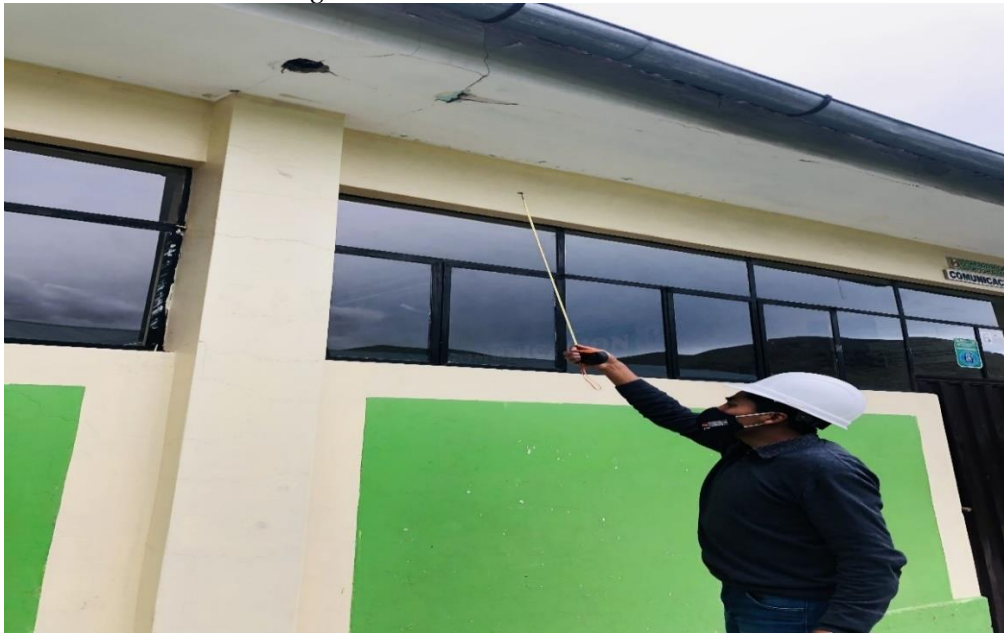
Figura 43: Elemento no estructural
