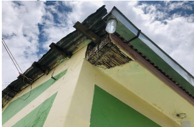
Figura 35: Elemento no estructural
