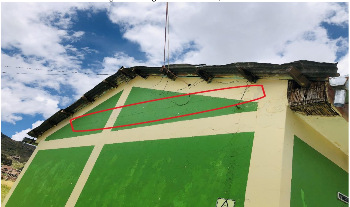
Figura 11: Agrietamiento horizontal
