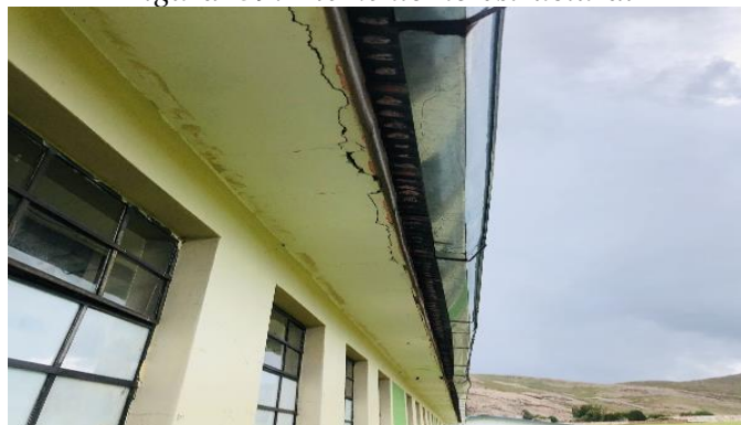
Figura 39: Elemento no estructural
