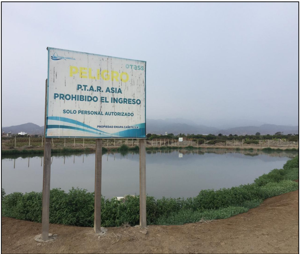
Figura N° 15: Planta de tratamiento de agua residuales
