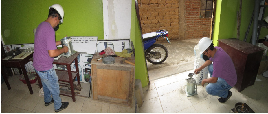
Figura 16 pesado y colocado del agregado en capas compactadas Fuente: Propia
