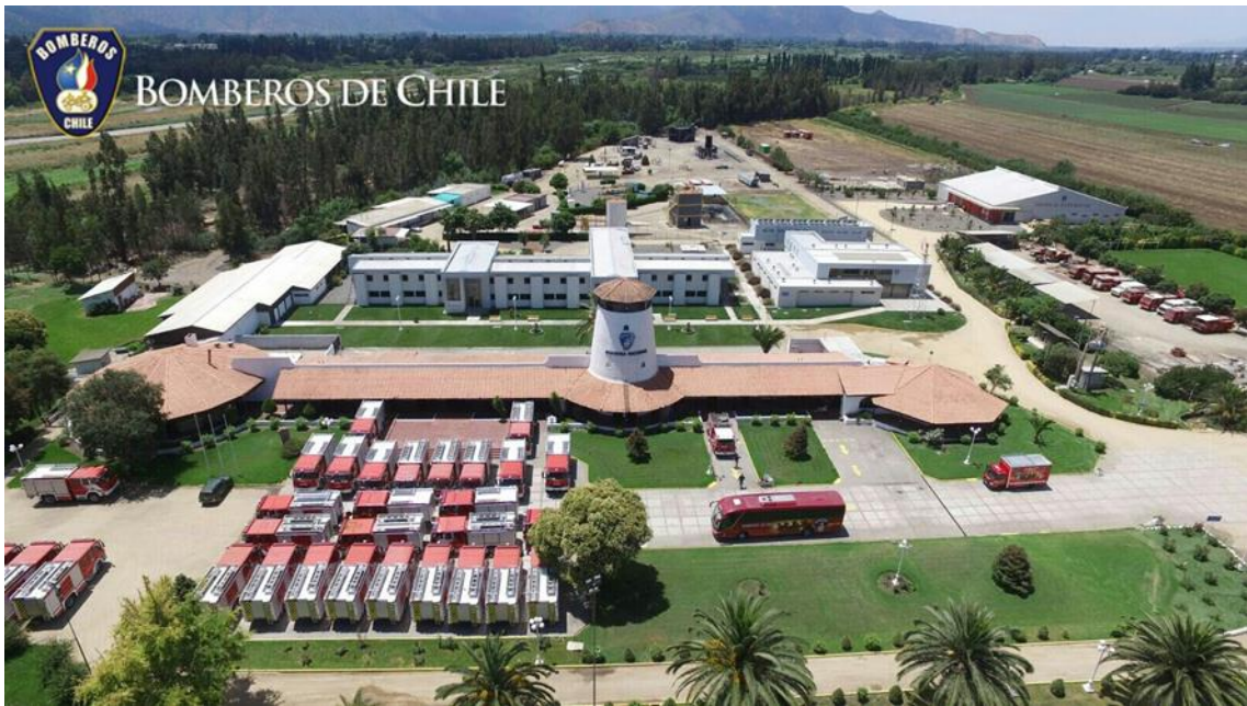
Fotografía: Vista aérea de Academia Nacional de Bomberos Chile – Centro de Entrenamiento del Campus Central Fuente: Página web: bomberos Chile ( http://www.cl/centros-deentrenamiento/centro-de-entrenamiento-del-campus-central/ )
