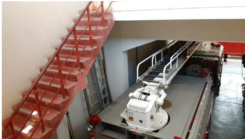
Ilustración N° 14 Escaleras para acceder a la segunda planta donde se encuentran los dormitorios Elaboración: Propia
