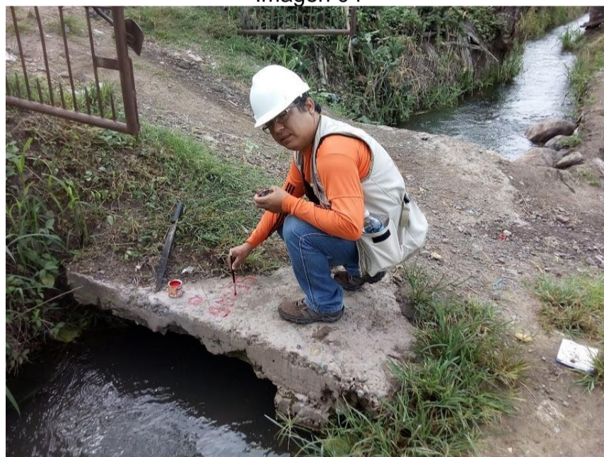
Marcación de BM en el proceso de levantamiento topográfico de la vía
