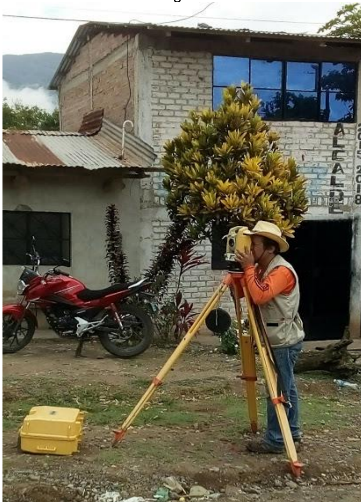
El investigador realizando la captación de los puntos con la estación
