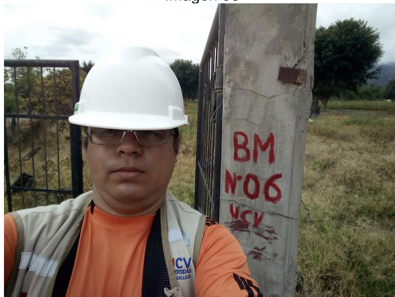
Punto BM 06 levantamiento topográfico del proyecto
