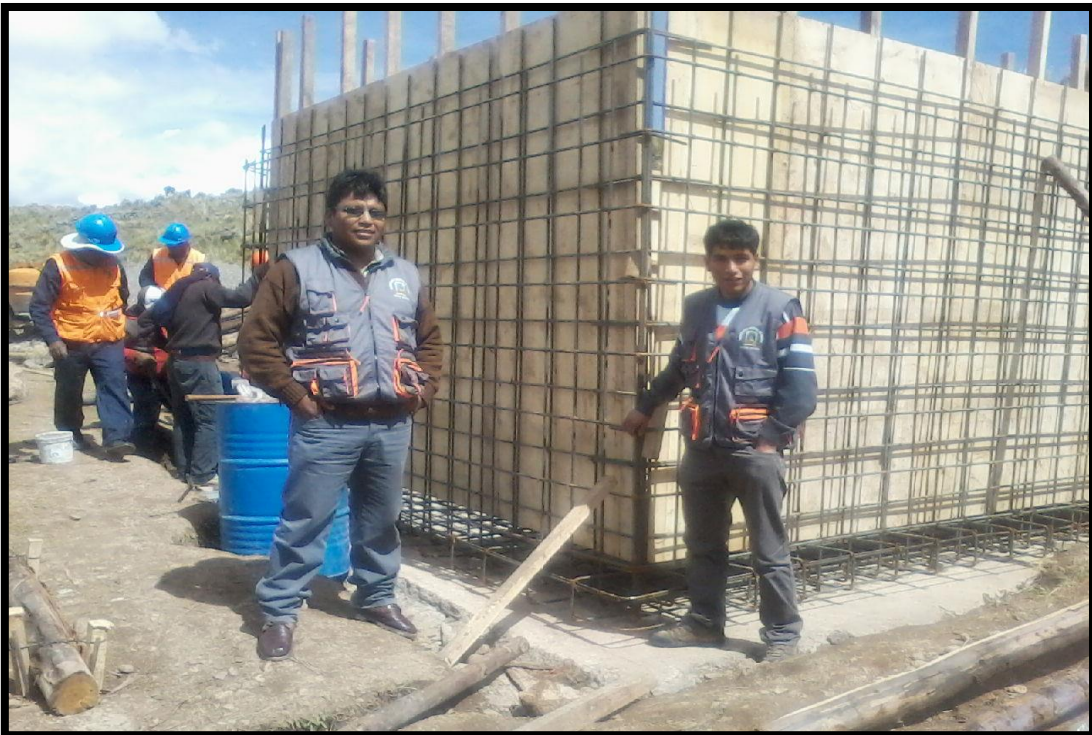
Fotografía 6 estructura de reservorio
