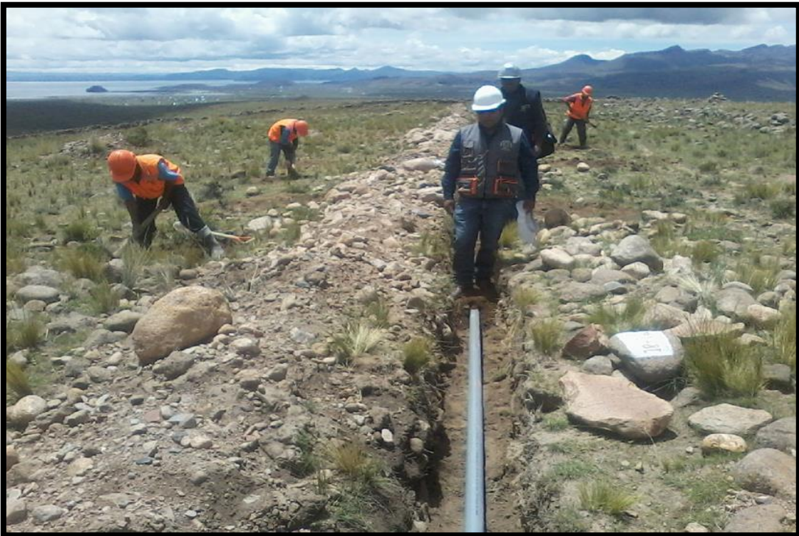
Fotografía 3 Línea de conducción
