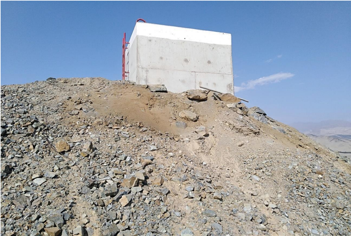
Anexo 7: Cámara de carga de minicentral hidroeléctrica
