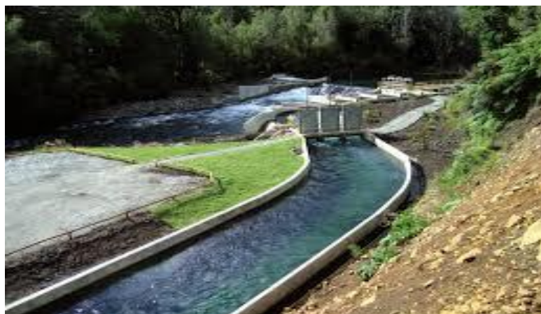
Figura 4: Central hidroeléctrica en canal de riego
