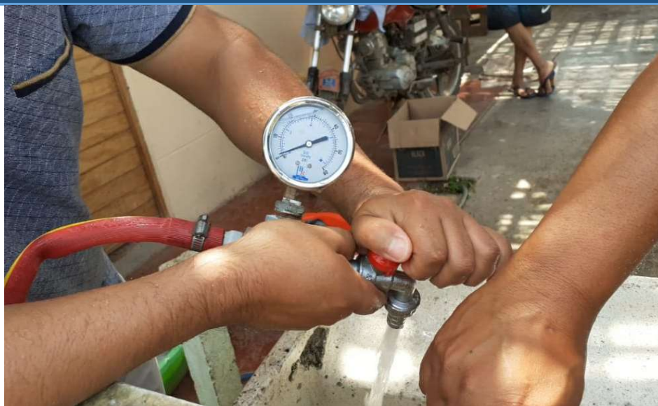
Figura 16. Toma de presión, de conexión domiciliaria a red de distribución existente.
