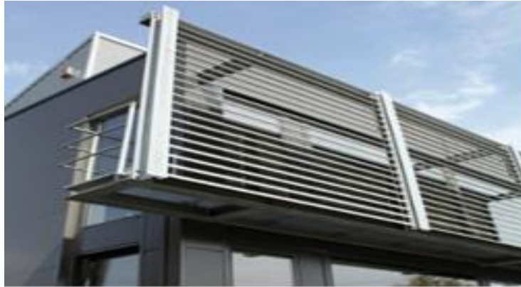
Figura 51: Persianas regulables de acero. Recuperado Arrevol (2016).
