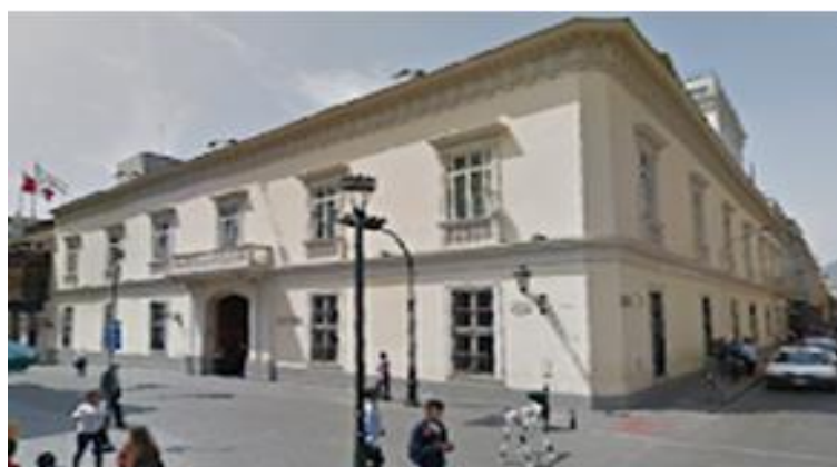
Figura 7: Centro de Cultural Inca Garcilaso. Recuperado del portal web del centro cultural Inca Garcilaso
