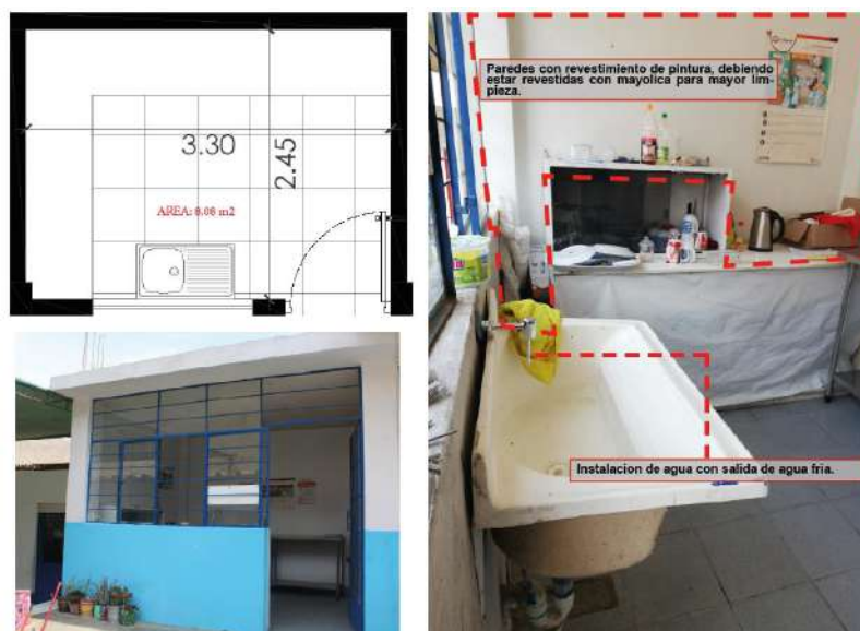
Figura 3. Insuficiente e inadecuada condicion arquitectonica de la cocina.
