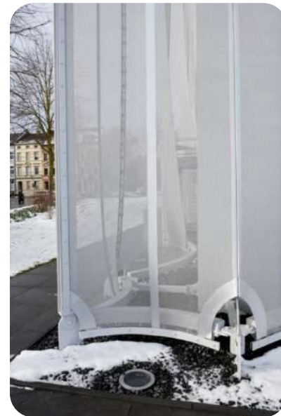
Figura 42. Detalle de fachada Fuente: archdaily.com
