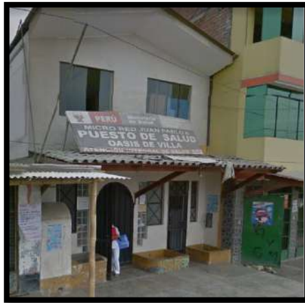
Figura 26. Puesto de salud "Oasis de Villa" Fuente: Google earth
