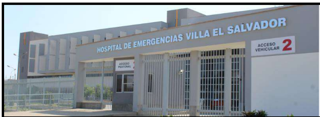
Figura 16. Foto Hospital de Emergencias Villa El Salvador Fuente: Municipalidad de Villa El Salvador
