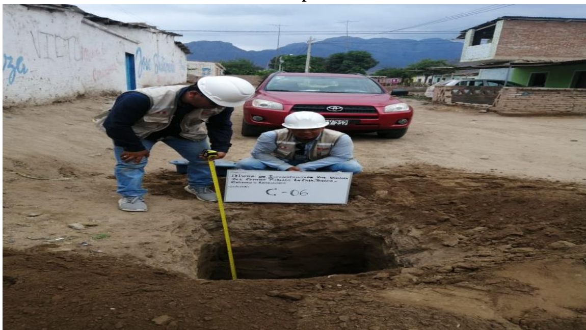
Foto 11 de campo: Calicata 06
