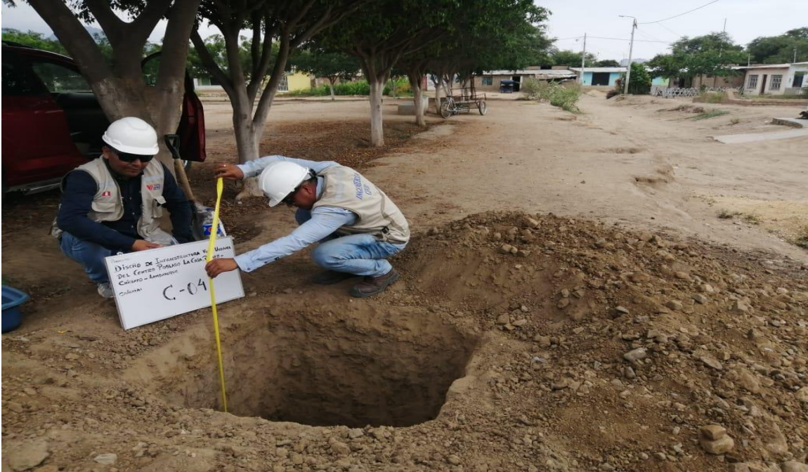
Foto 9 de campo: Calicata 04
