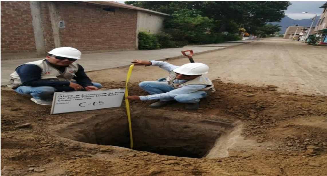
Foto 10 de campo: Calicata 05
