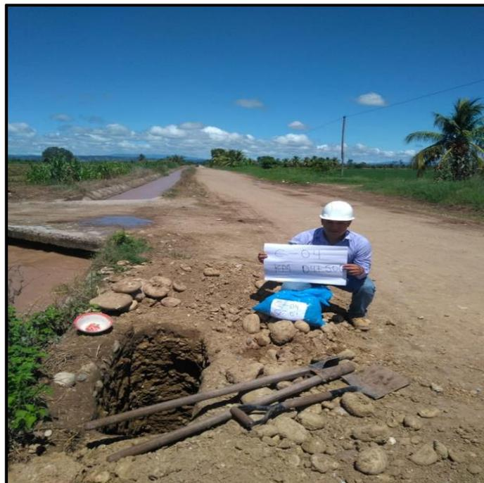
**Descripción:** Se aprecia los trabajos de exploración de campo, en la cual se realizó excavación de calicatas cada 1000 metros. De acuerdo a lo establecido MTC.
