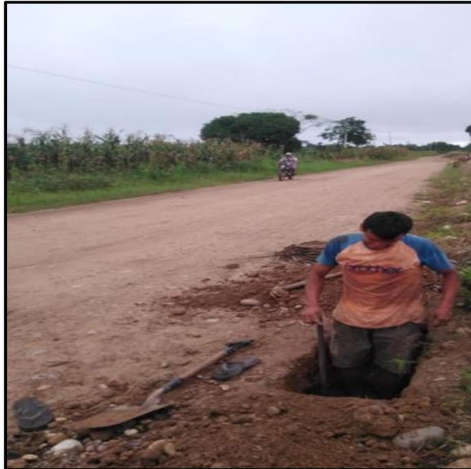
**Descripción:** Se aprecia la excavación de las calicatas, en el tramo caserío (San José – C.P. Carhuapoma). utilizando herramientas manuales (palana, cavadora y pico).
