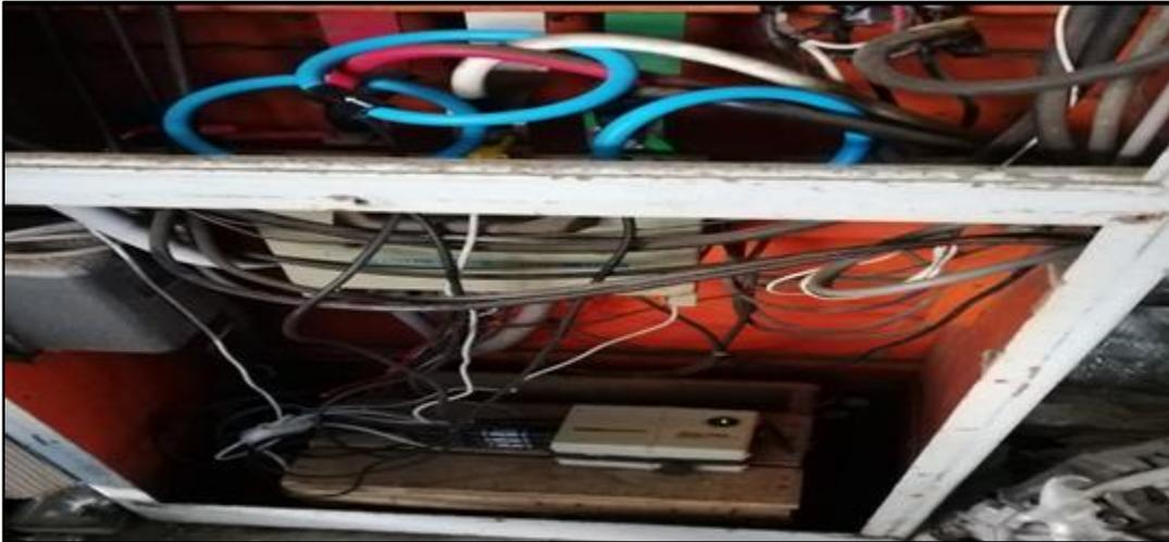
*Figura 15 Conexión del analizador de redes en el tablero general*
