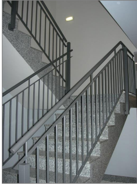
Baranda Metálica en las terrazas
