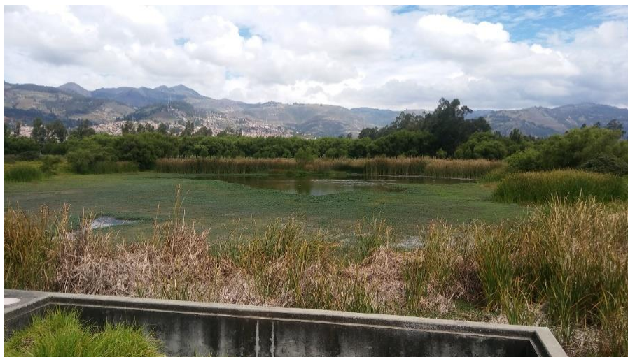
Lagunas de oxidación Cajamarca
