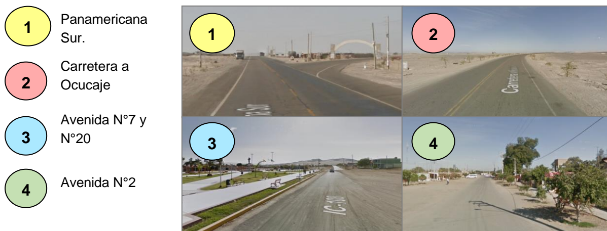
Figura 24: Fotos de vías pavimentadas.
