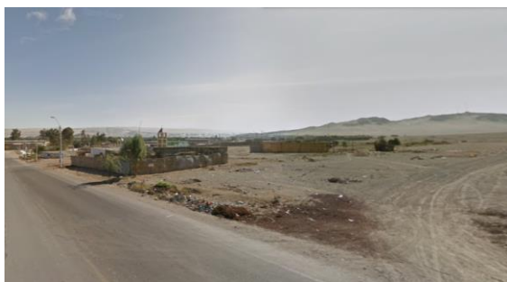
Figura 35: Ingreso de la carreta a Ocucaje
