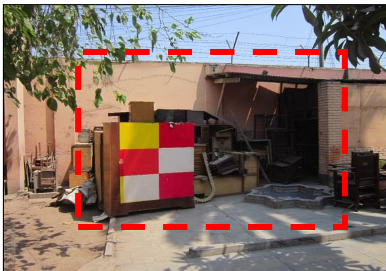
Figura 15: Se observa mediante la fotografía, las insuficientes e inadecuadas condiciones arquitectónicas del área de servicios complementarios.
