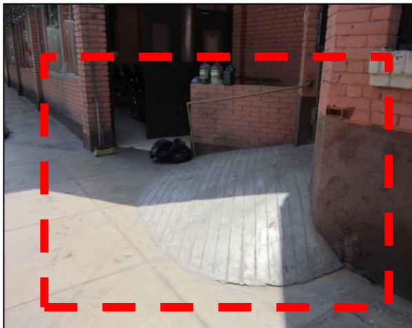
Figura 8: Rampas no cumple con las Normas según el R.N.E. y con las medidas reglamentarias.
