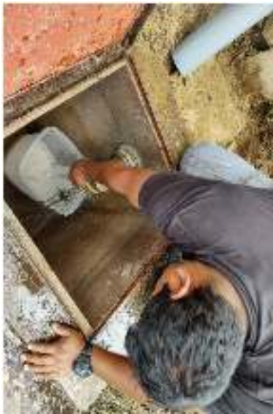
Foto N° 18: Aforo en la Cámara Rompe Presión en la Linea de Conduccion
