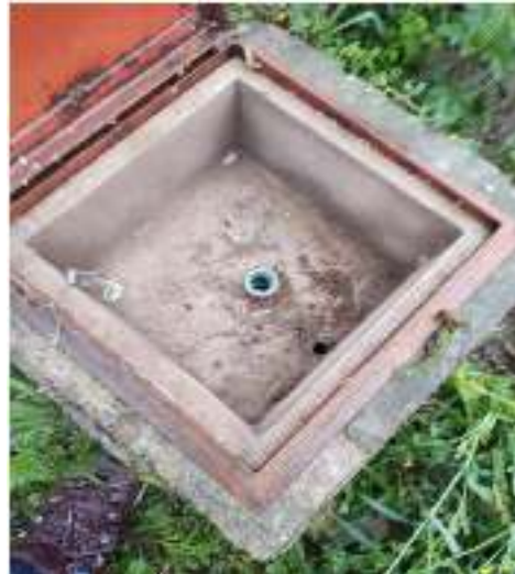
Foto N° 25: Falta de Mantenimiento en Hidrantes
