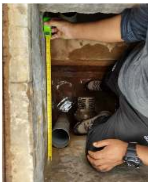
Foto N° 13: Cámara Rompe Presión Tipo 7 en la Línea de Conduccion
