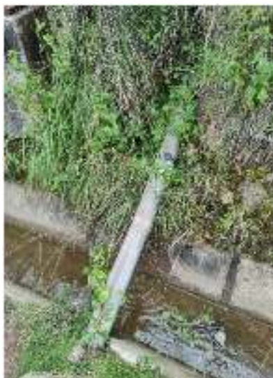
Foto N° 15: Presencia de Maleza en las Cajas de Válvulas de Control en la Línea de Distribución
