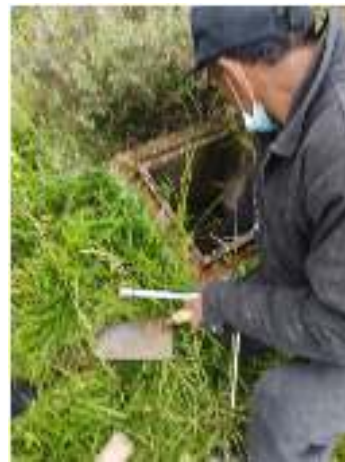
Foto N° 4: Toma de datos de hidrantes
