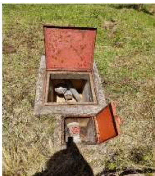
Foto N° 13: Cámara Rompe Presión Tipo 7 en la Línea de Conduccion
