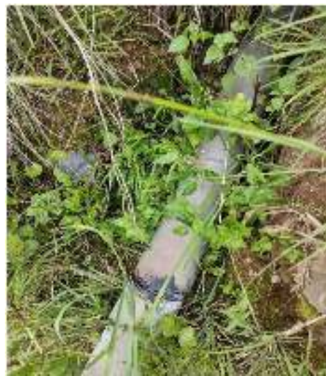
Foto N° 15: Presencia de Maleza en las Cajas de Válvulas de Control en la Línea de Distribución
