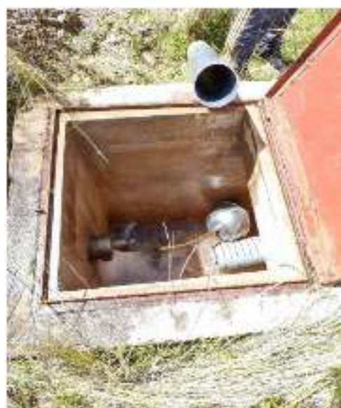
Foto N° 13: Cámara Rompe Presión Tipo 7 en la Línea de Conduccion
