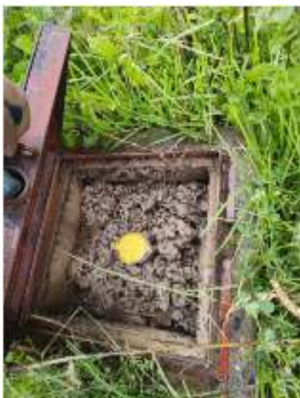
Foto N° 25: Falta de Mantenimiento en Hidrantes
