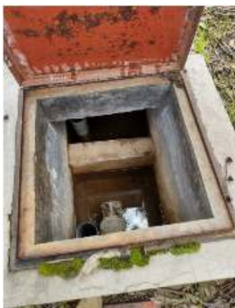
Foto N° 13: Cámara Rompe Presión Tipo 7 en la Línea de Conduccion
