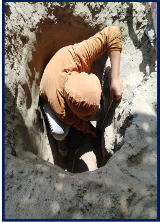
Excavación del terreno para evaluación de la cimentación de las viviendas
