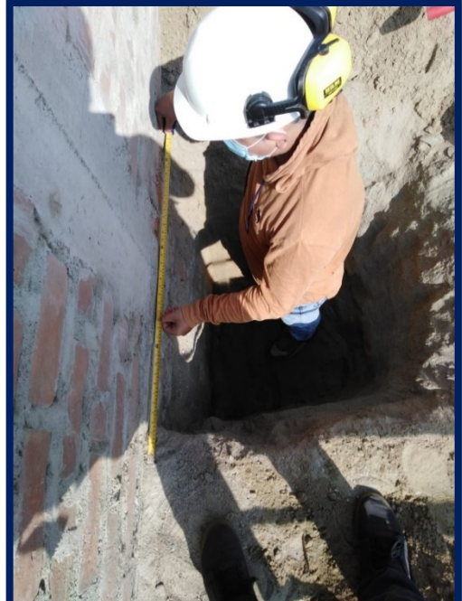
Medición de las dimensiones de la cimentación de las viviendas
