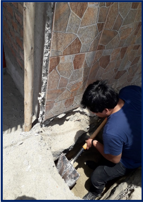
Excavación del terreno para evaluación de la cimentación de las viviendas
