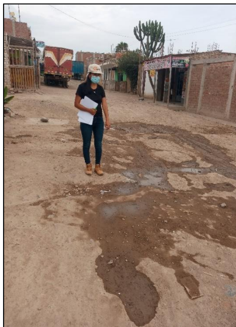
Figura 14. En la imagen se evidencia la disposición final del agua de uso doméstico
