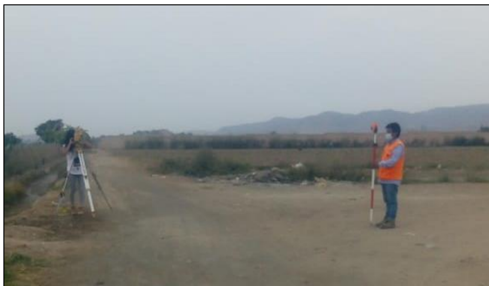
Figura 23.. Levantamiento de la calle, 18 de febrero.
