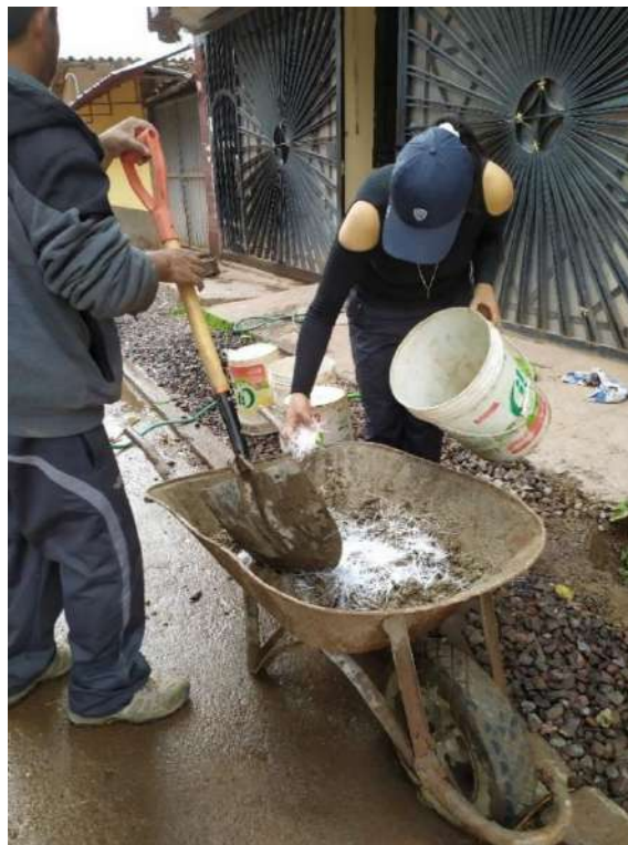
Figura N° 13: Preparación del concreto adicionando la fibra Fuente: Elaboración propia
