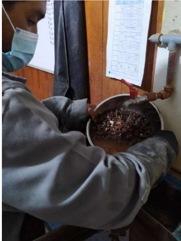
Figura N° 06: Lavado de los agregados Fuente: Elaboración propia
