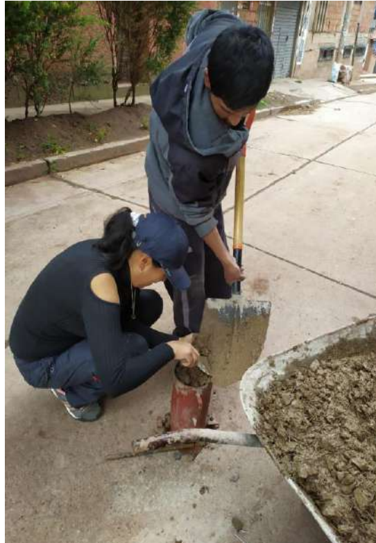
Figura N° 14: Colocación del concreto Fuente: Elaboración propia
