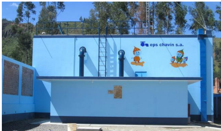
Figura 30. Reservorio automatizado Fuente: (EPS-Chavin, 2016)
