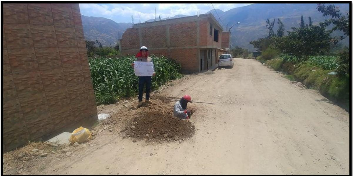
**Figura 27.** Toma 1 de excavación de calicata n° 01 a 0+120 km.
