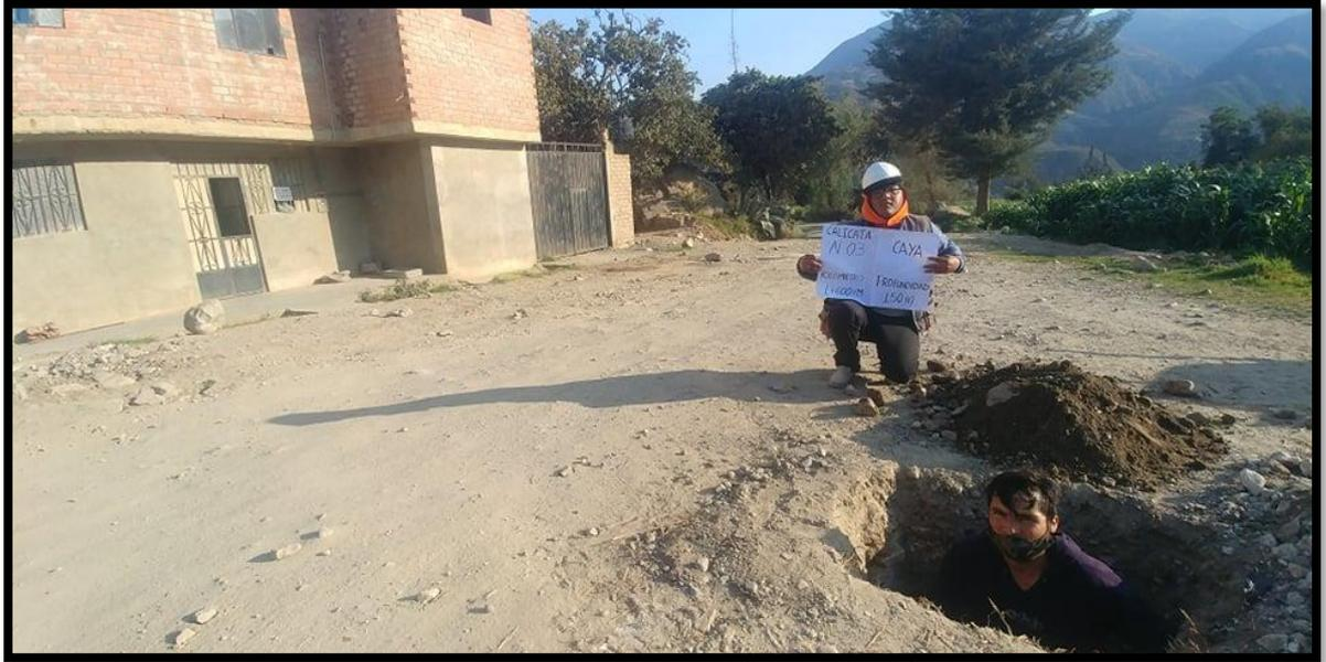
**Figura 30.** Excavación de calicata n° 03 a 1+600 km.
