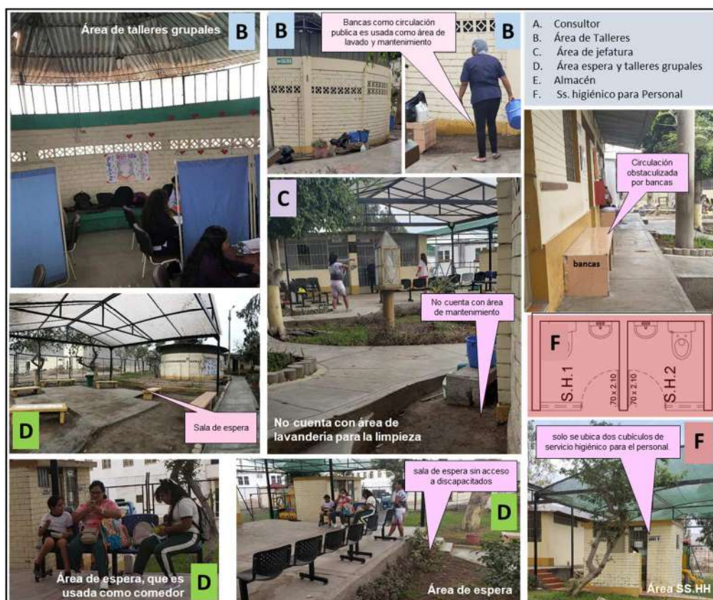
Figura 26. Estado actual de los sectores del área de psicología.
