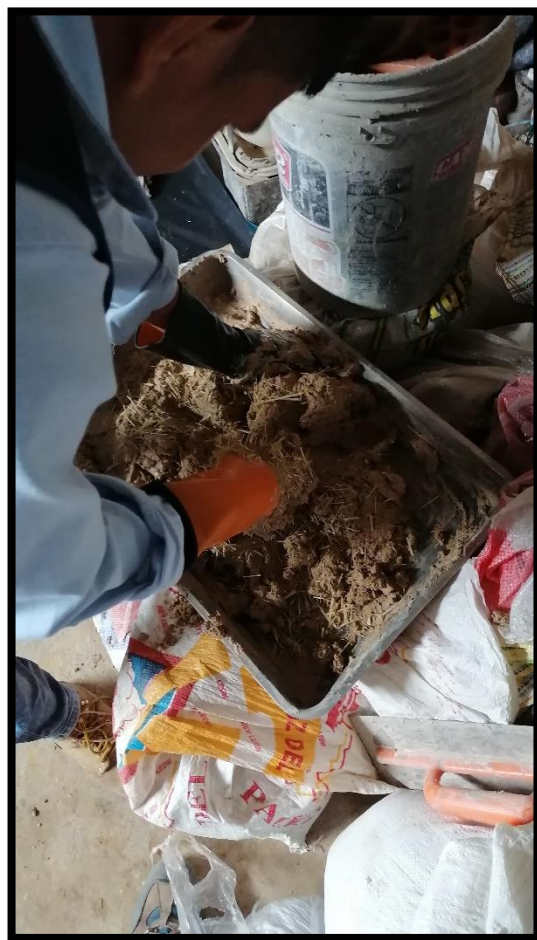
Figura 22. Amasado para homogenización de la fibra de bambú y la arcilla.
