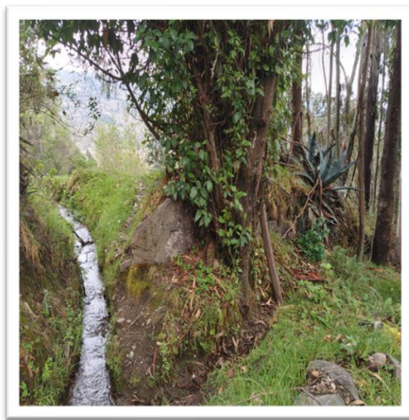
Figura 1 Canal rustico de tierra con pérdidas de agua
