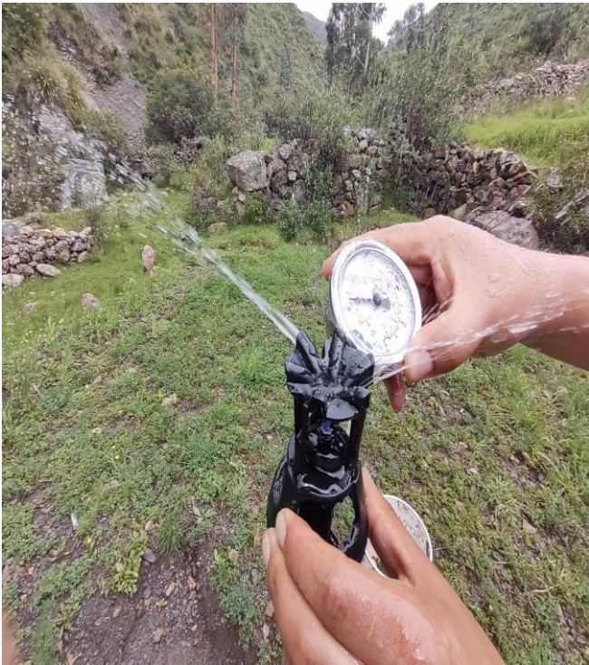
Medición de presión del Aspensor Xcel
