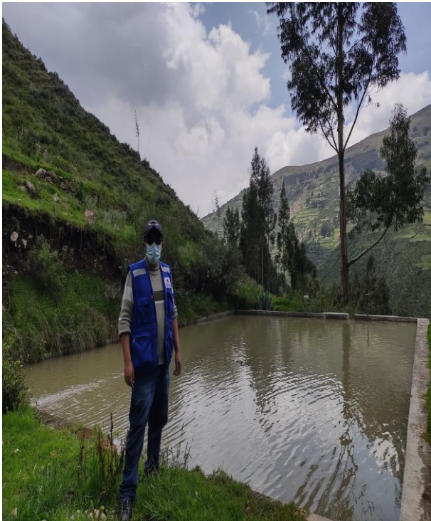
Vista del reservorio en su máximo nivel de Agua
