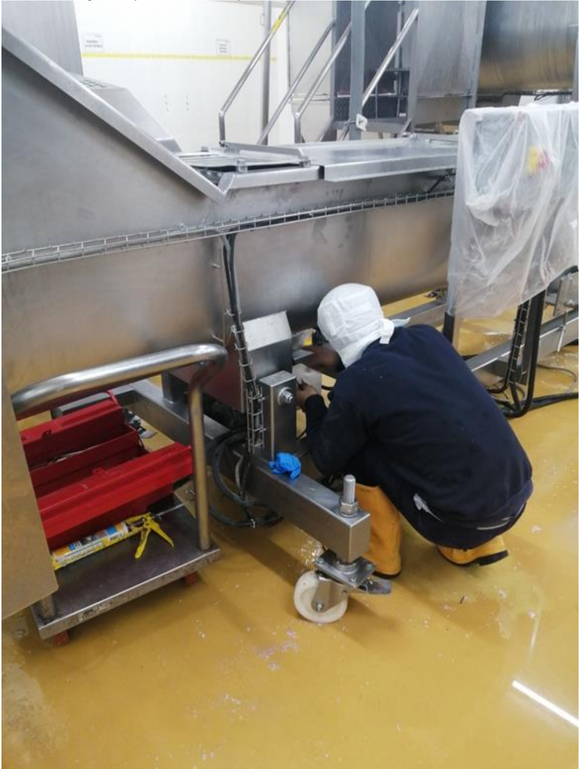
Anexo 14: Imagen 2. Ejecución del trabajo de mantenimiento correctivo.
