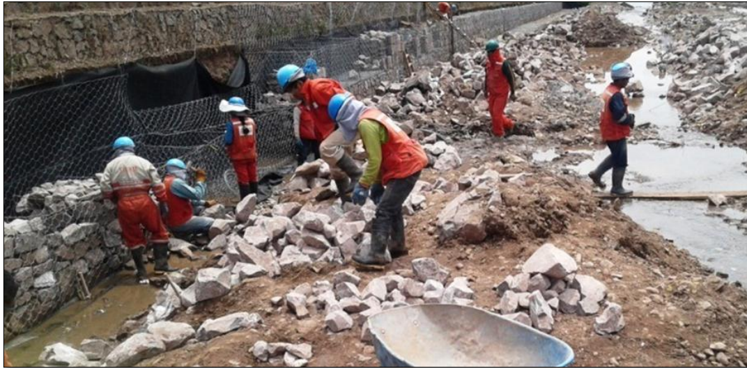
Figura 9. Personal sin entrenamiento para construcción de Gavión (Antes)
