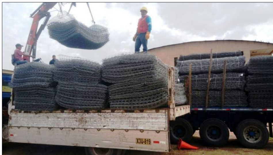
Figura 20. Carguío, Transporte, Descarga con camión Grúa (Después)
