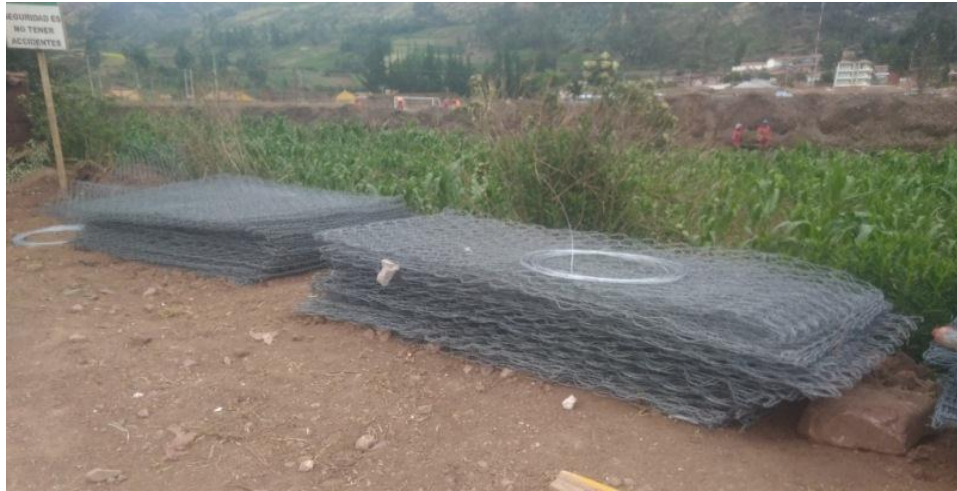
Figura 19. Evidencia de cómo llegan los gaviones para ser armados.
