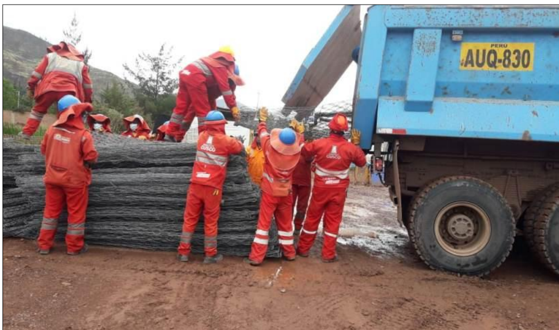
Figura 10. Carguío, Transporte, Descarga de gaviones en volquete (Antes)
