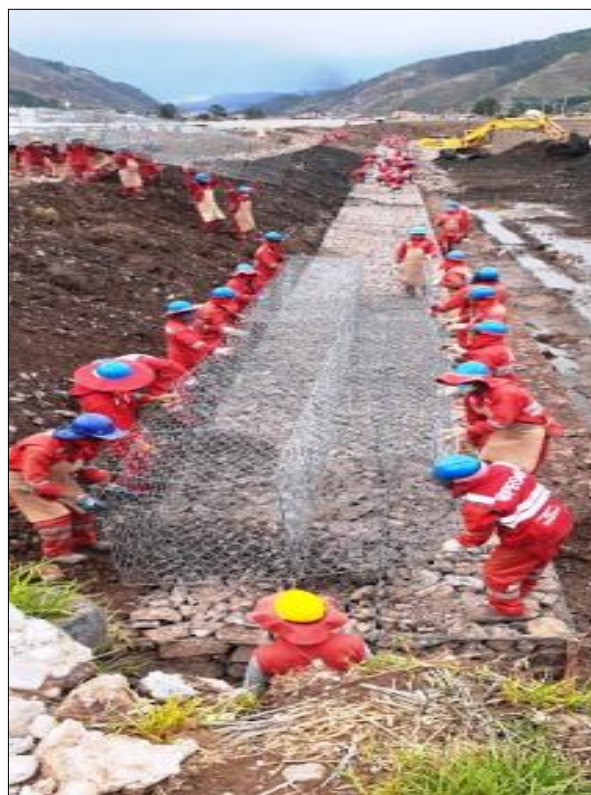
Figura 16. Evidencia de organización para el llenado de gavión (Después)
