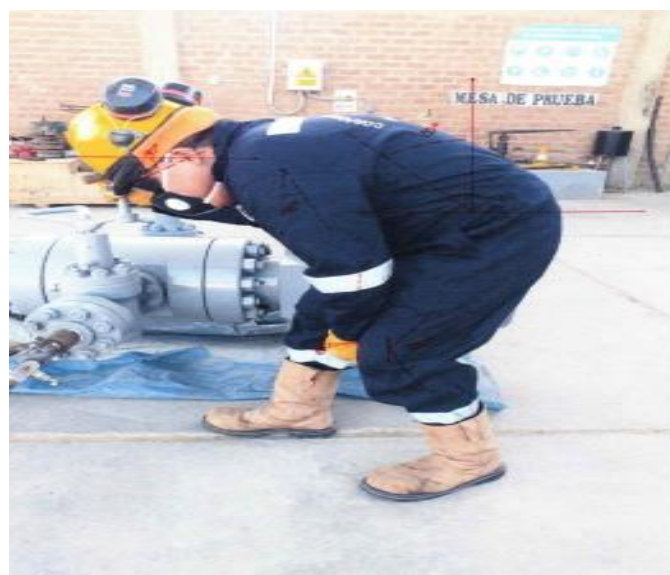
Ilustración 33. Verificación de presión.
