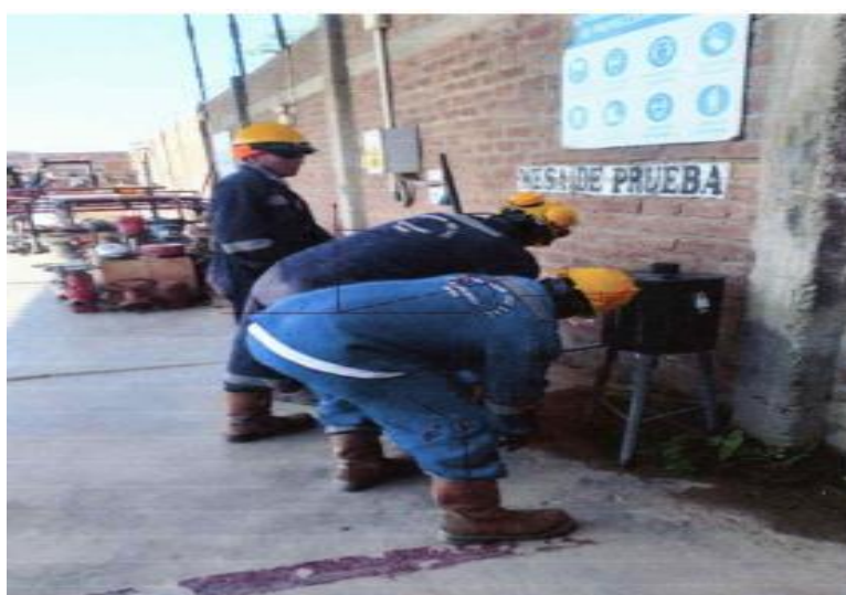
Ilustración 27. Bombeo de agua a Presión de más de 5000 psi.
