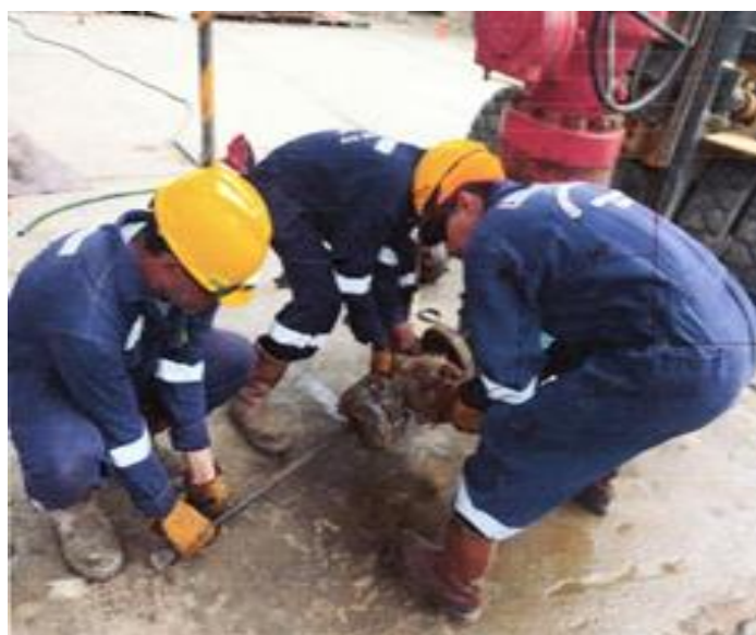
Ilustración 7. Desarme de las válvulas de baleo y accesorios.
