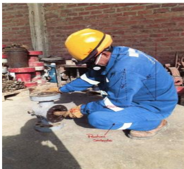
Ilustración 11. Limpieza de piezas internas.
