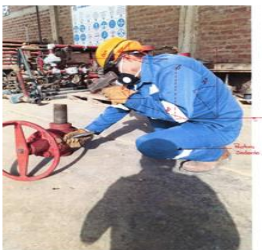
Ilustración 9. Desarmar las piezas de válvulas de baleo y laterales.
