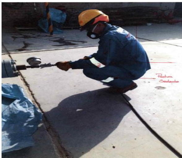
Ilustración 25. Conexión de manguera para hacer prueba de agua.
