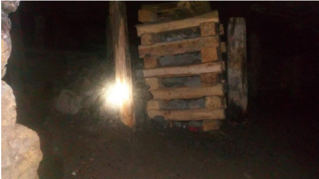
Figura 11. Paquete de madera con relleno estéril (6"x7"x3.3').
