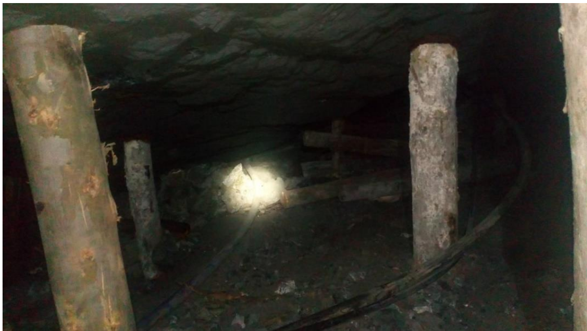
Figura 10. Puntales de madera (8"x5.5') con pre-tensionado Jack-pot.
