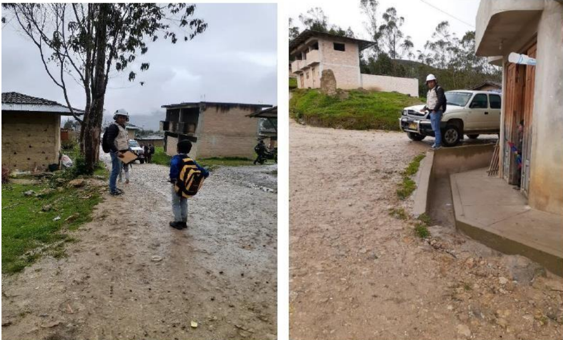
Figura 2. Vista de vías en mal estado, sin anchos mínimos recomendable
