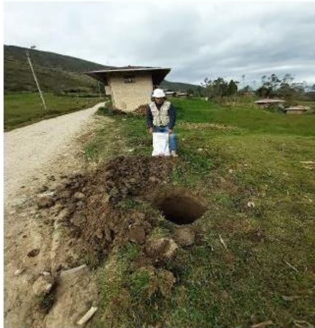
Figura 1: Excavación de calicata n° 2 progresiva KM 2+000
