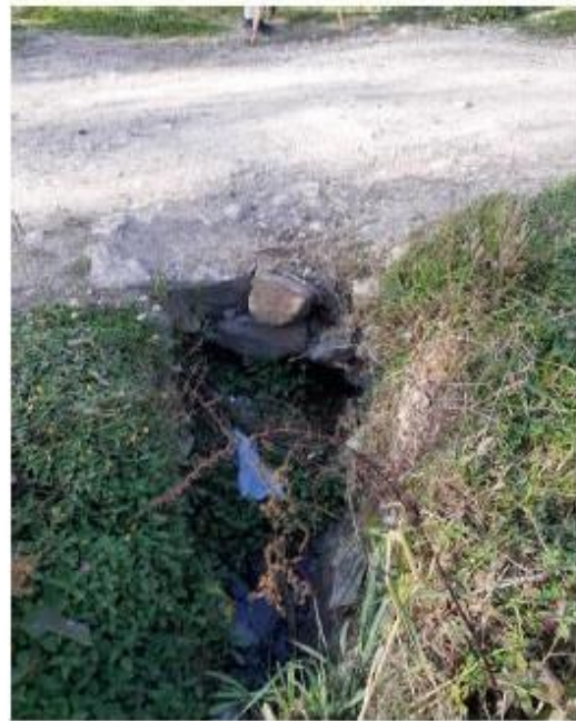
Figura 5. Observamos el estado actual de la alcantarilla
