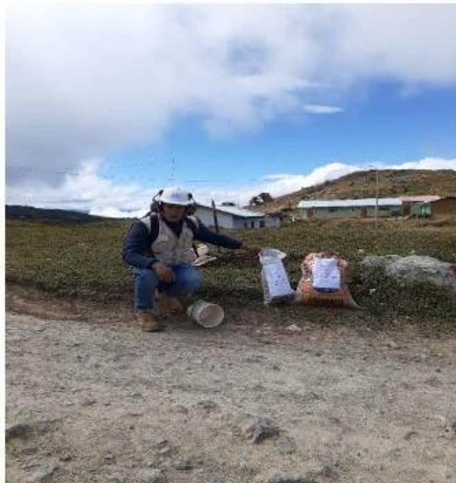
Figura 2: Excavación para muestra de calicata y CBR progresiva KM 6+000
