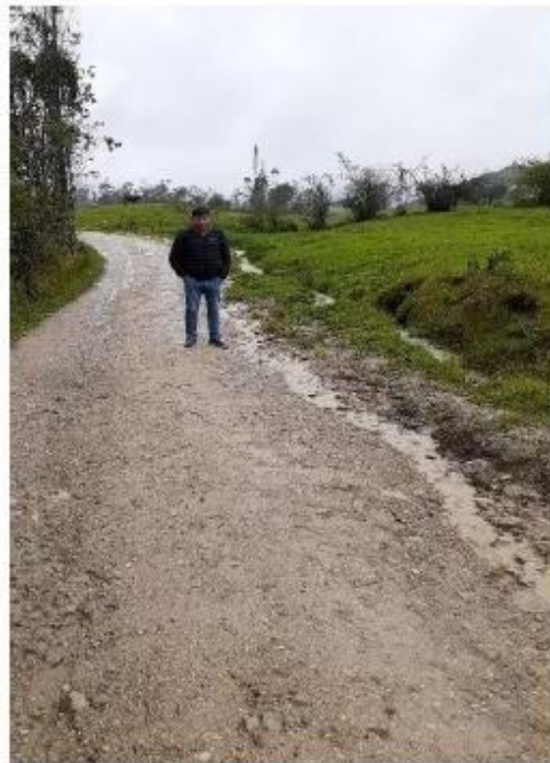
Figura 2 Estado de la vía.
