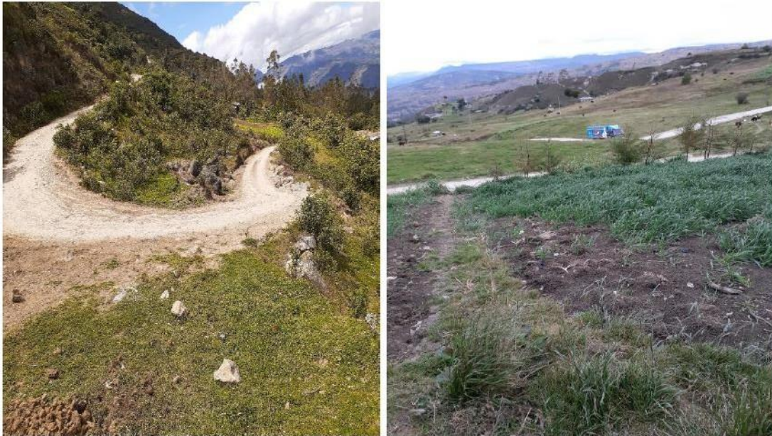
Figura 4. Vista Falta de señalización en curva y cruce.
