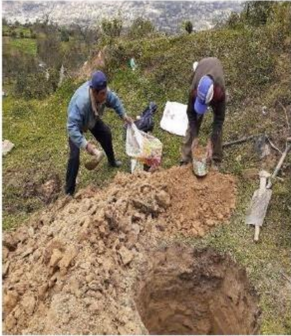
Figura 3: Excavación para muestra de calicata
