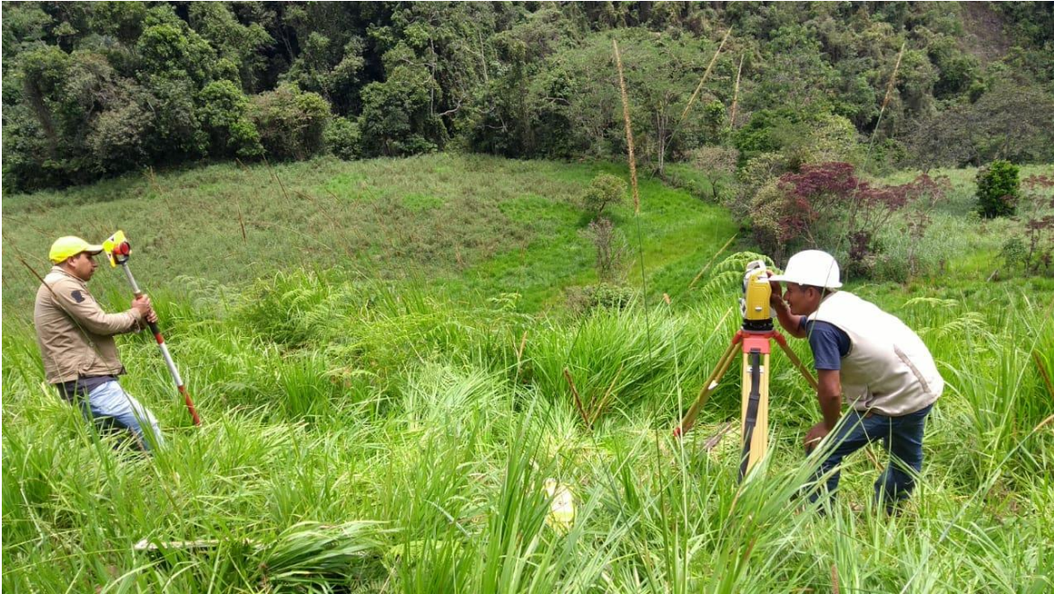
Foto N° 3: Levantamiento topográfico de sección transversal cada 20 m y 10 m
