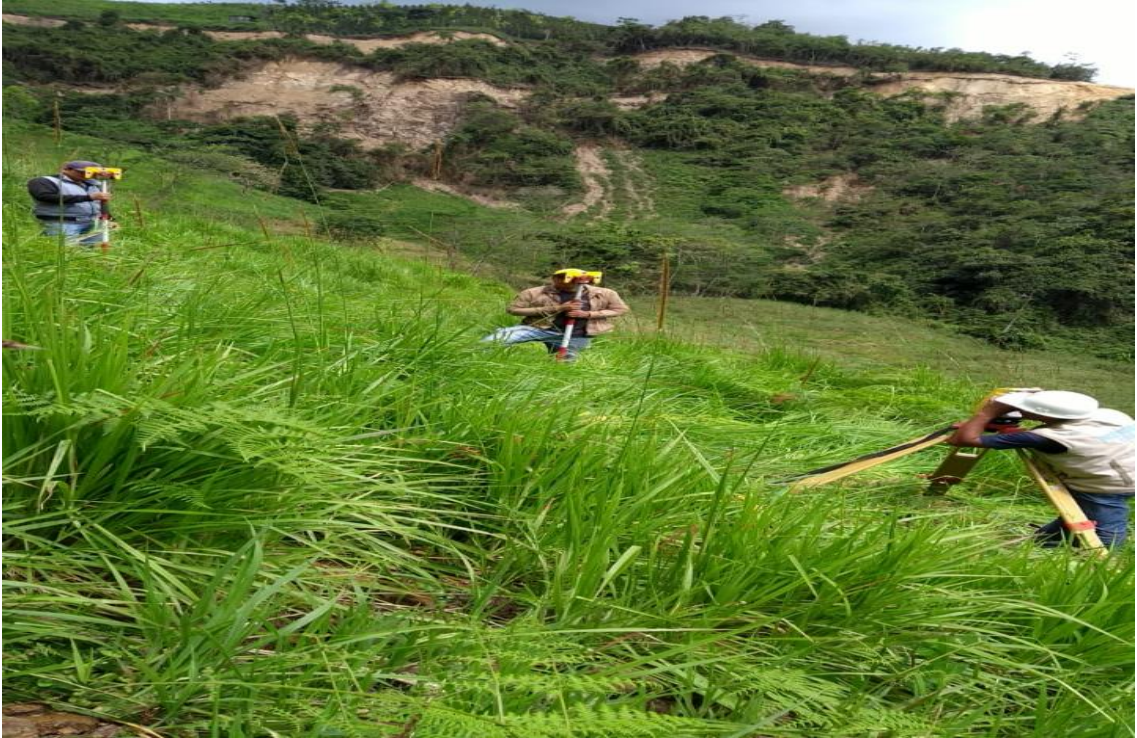
Foto N° 4: Levantamiento topográfico de sección transversal cada 20 m y 10 m
