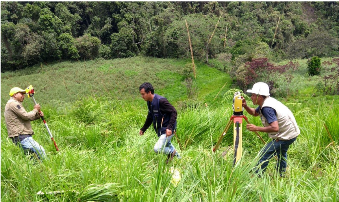
Foto N° 6: Monumentación de BM
