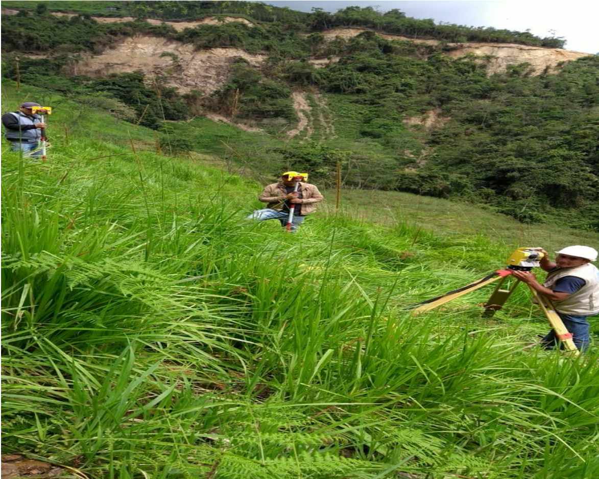
Foto N° 5: Levantamiento topográfico de viviendas aledañas a lo largo de la vía
