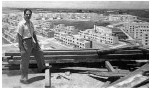
Figura 3. Unidad vecinal N° 03. Recuperado de http://laformamodernaenlatinoamerica.blogspot.com/2014/08/expropiacion-de-la-unidad-vecinal-n-3.html
