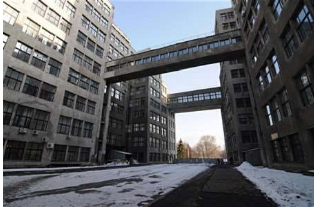
Figura 11. Unión de bloques. Recuperado de https://magnet.xataka.com/un-mundo-fascinante/19-joyzas-de-la-arquitectura-comunista/
