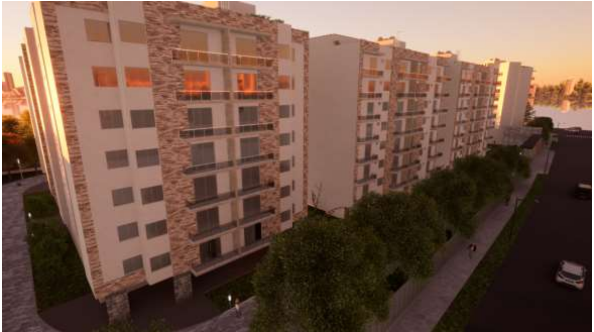
Figura 96. Fachadas de edificios. Elaboración propia. Captura de video 3D
