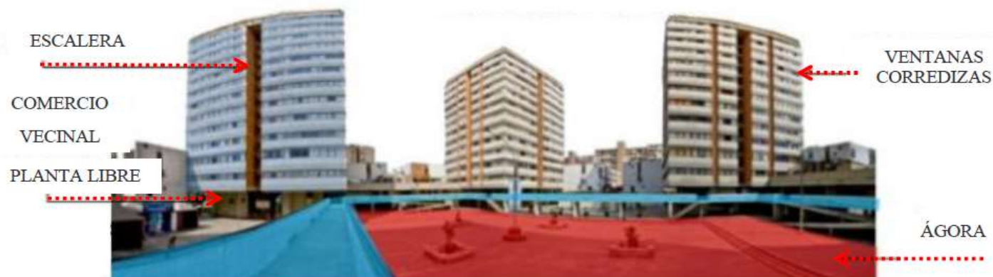
EDIFICIO DE 14 NIVELES
