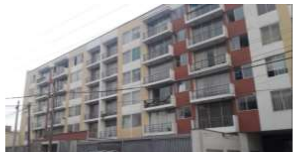
Figura 74. Conjunto Residencial “Las torres de Ate”. Elaboración propia.
