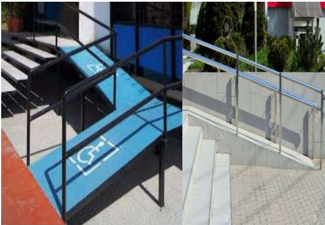
Figura 108. Rampas y descansos para personas con discapacidad móvil. Planeamiento y Diseño Establecimientos de Salud.
