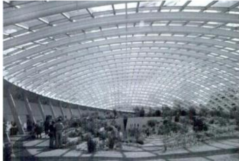
Figura 15. Vista interior de la cubierta en forma de arcos.
