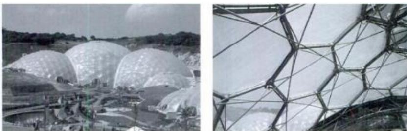
Figura 14. Vista aérea y detalle interior tridimensional de la cubierta de cáscara.
