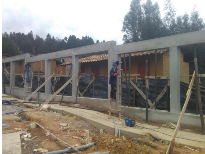
Figura 13: Proceso de Montaje de tubería
