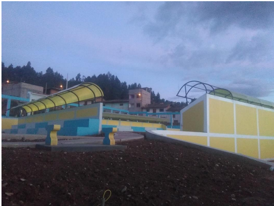
Fuente: Proyecto de infraestructura
