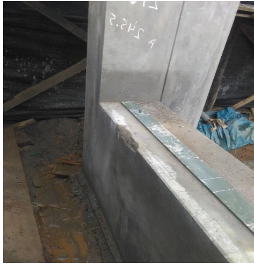
Figura 9: Montaje de parte inferior platina
