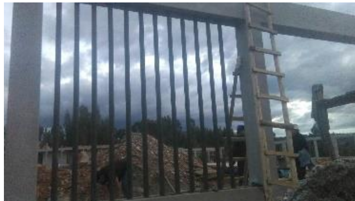
Figura 14: Montaje de tubería concretado
