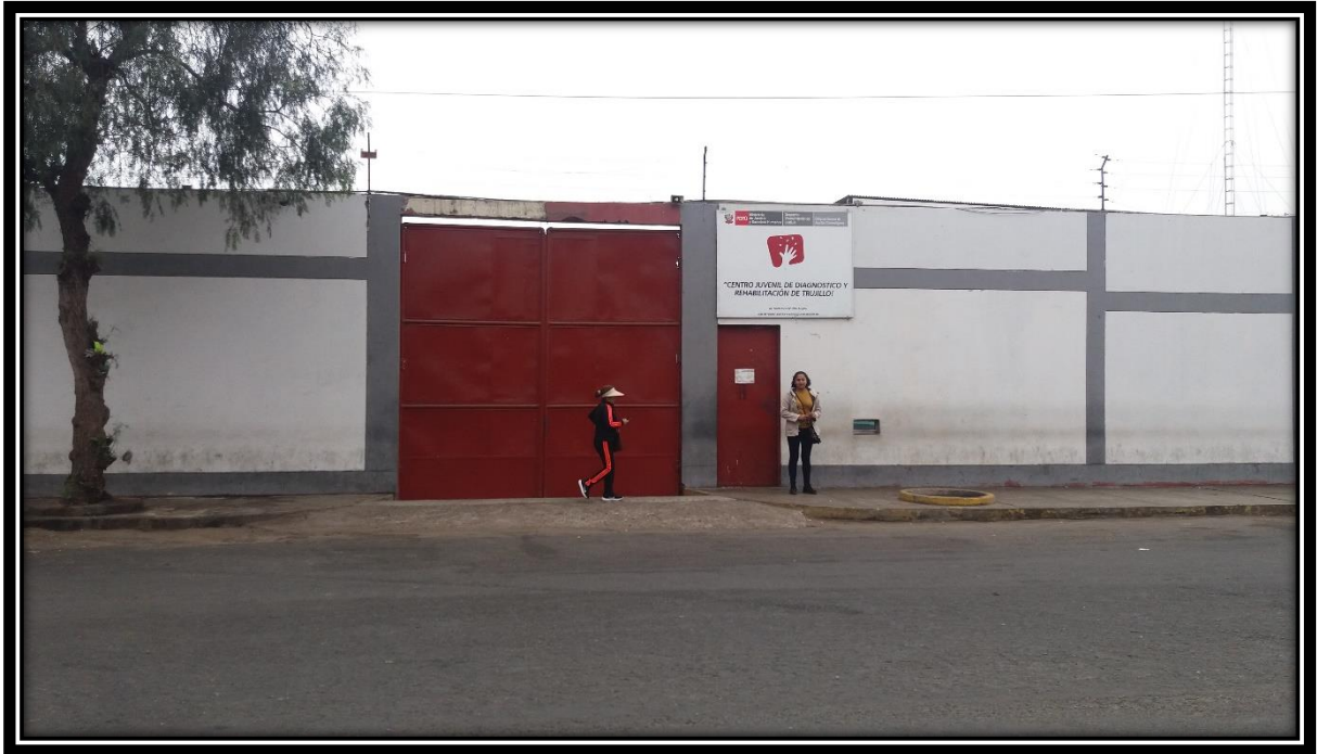
Figura 9: Realizando visita correspondiente al Centro de Rehabilitación EX FLORESTA.
