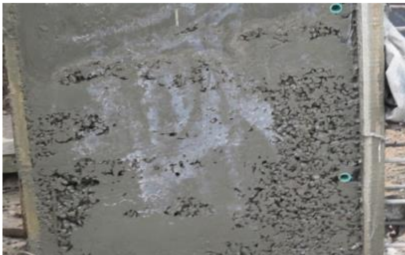
Figura 9: Segregación de Columnas Estructura Fuente: Universidad Militar Nueva Granada
