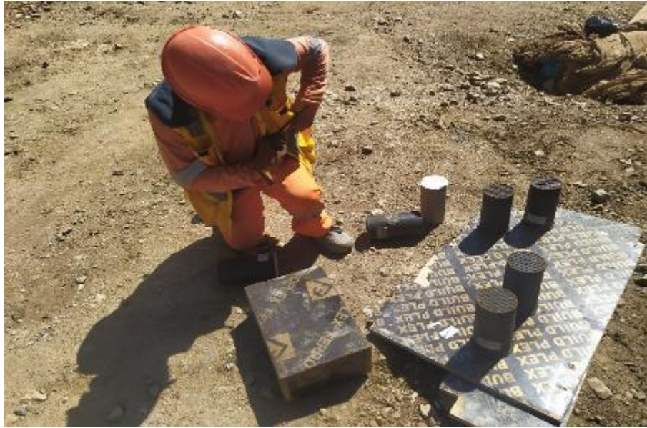
Figura 28. Desmolde de probetas de concreto de 100mm x 200 mm Fuente: Elaboración Propia
