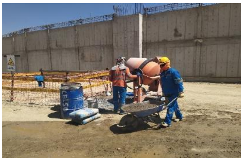
Figura 11: Pleno proceso de Elaboración de Concreto Fuente: Elaboración Propia
