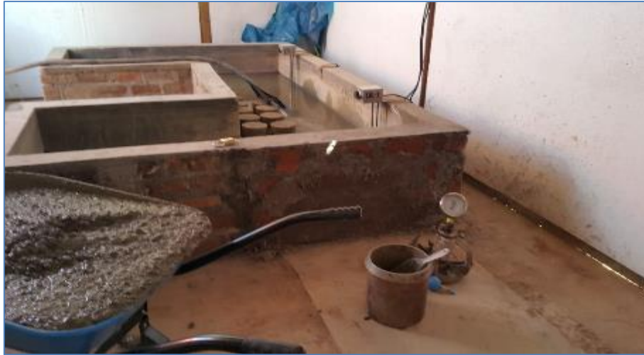
Figura 31. Poza de Curado en Obra Fuente: Elaboración Propia
