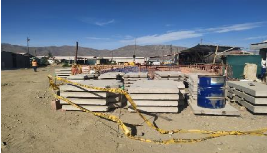
Figura 22. Paneles de Muros Prefabricados Fuente: Elaboración Propia
