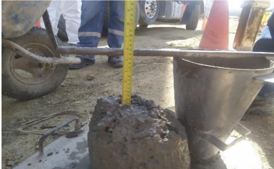
Figura 25: Determinación del asentamiento del concreto Fuente: Producción Propia
