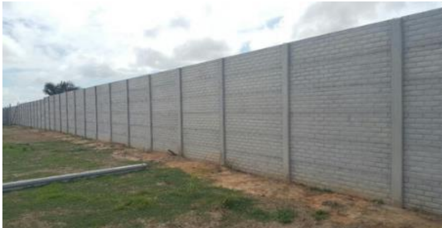
Figura 23: Cerco Prefabricado Fuente: Obtención Propia
