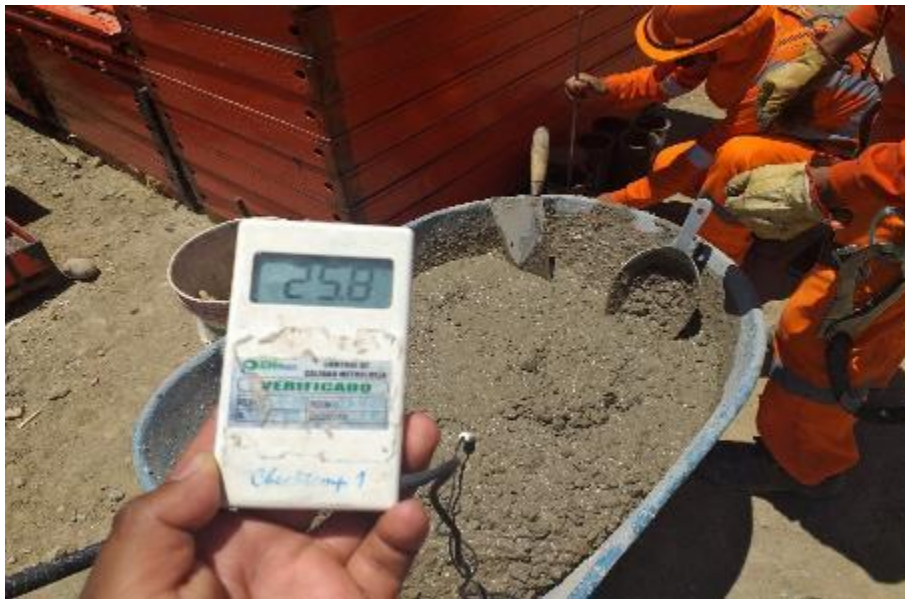
Figura 26. Medición de Temperatura 25.8 °C se encuentra dentro del rango Fuente: Obtención Propia
