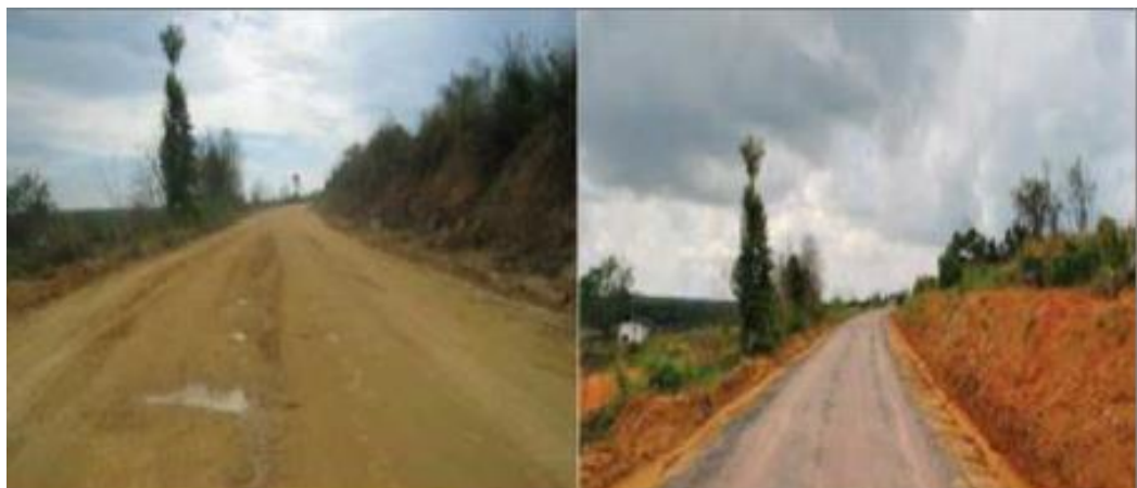
Figura 11. Estabilizacion del suelo (antes y después), por Lim et al., 2014, p. 210
