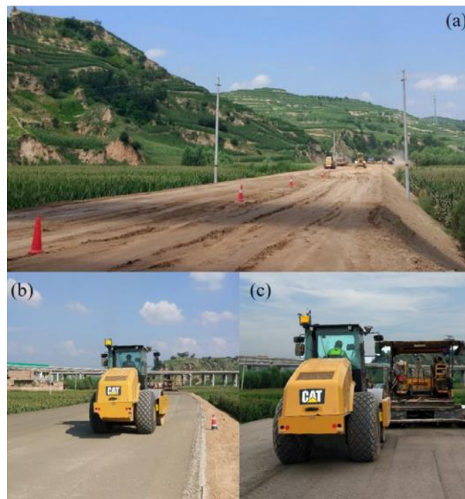
Figura 6. Compactación en diferentes conformaciones, (a) Compactación de sub rasan (b) Compactación de sub base(c) Compactación de base, por Zhu et al., 2018, p. 319
