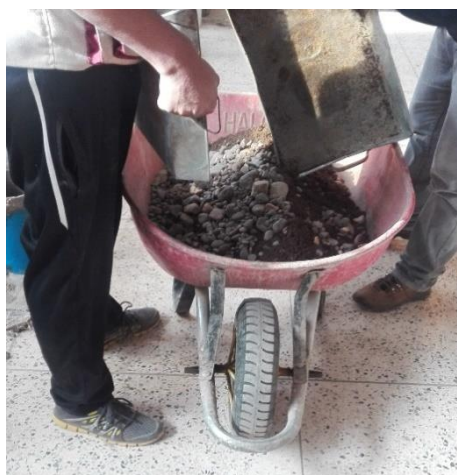
FOTOGRAFÍA N° 9: Mezcla de áridos granulares con el cemento
