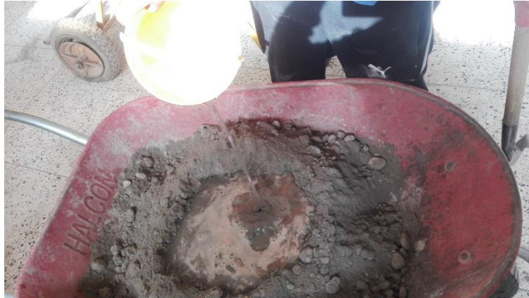
FOTOGRAFÍA N° 11: Proceso del mezclado del concreto
