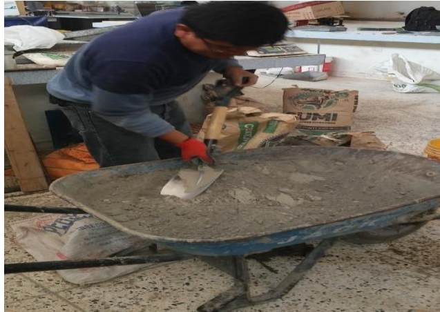
FOTOGRAFÍA N° 14: Mezcla del concreto
