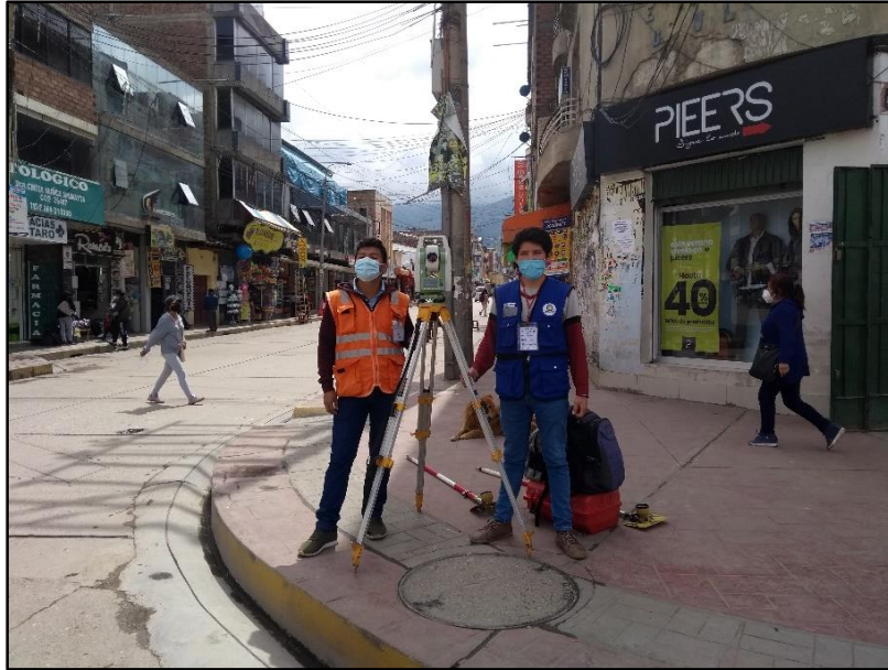
Fotografía 5: Inicio de trabajo topográfico en el Jirón Cajamarca tramo 1.
