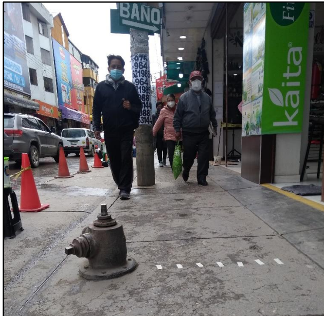
Fotografía 30: Medición para el factor de seguridad de alejamiento de Hidrante.
