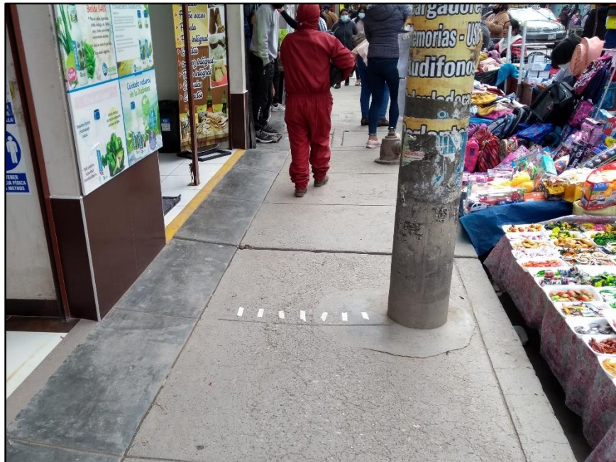
Fotografía 22: Medición para el factor de seguridad de alejamiento de Poste de Luz
