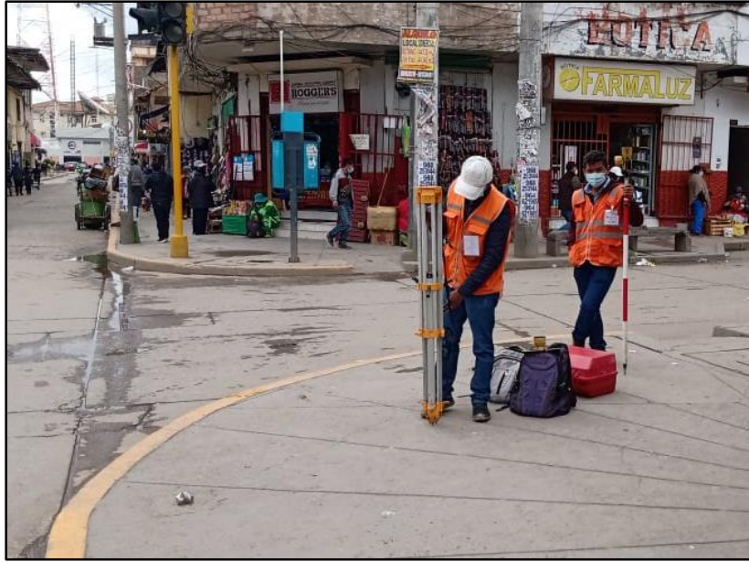
Fotografía 7: Estacionando el equipo en el tramo 2 del Jirón Cajamarca.
