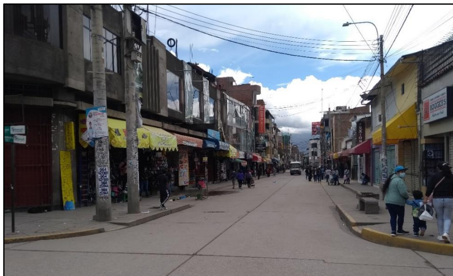
Fotografía 1: Reconocimiento de campo del tramo 1 del Jirón Cajamarca.
