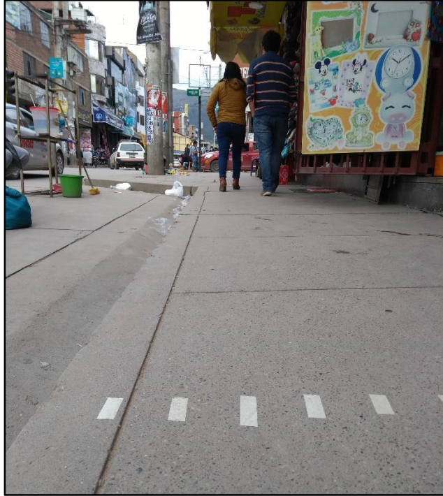
Fotografía 25: Medición para el factor de seguridad de alejamiento de los Bordillos
