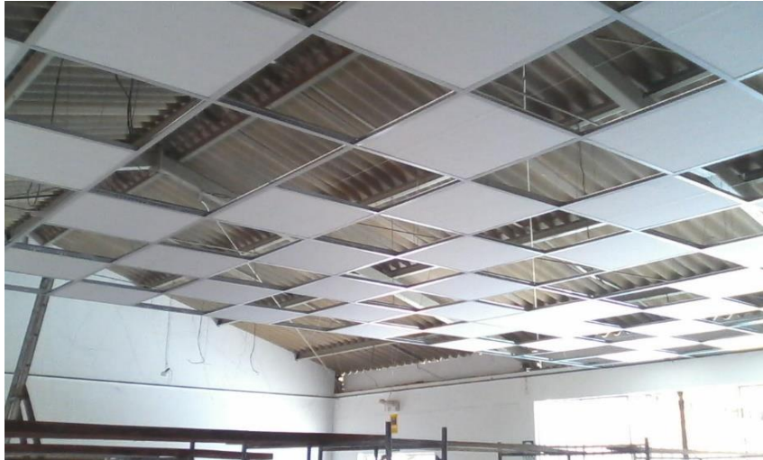
Figura 23: Cieloraso. Fuente: Consdrywall.
