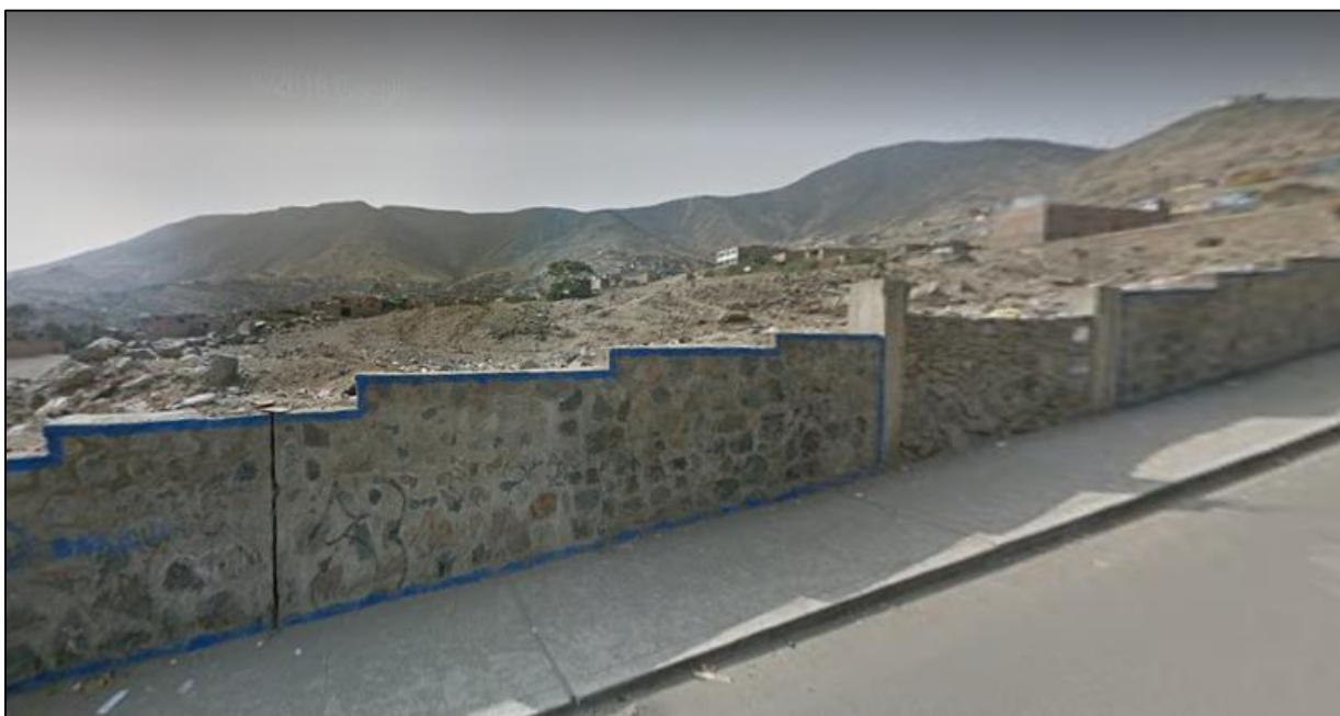
Figura 6: Vista desde el Jr. Micaela Bastidas. Fuente: Elaboración Propia.
