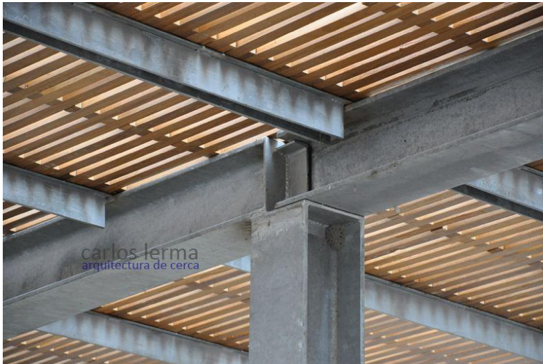
Figura 19: Viga Metálica. Fuente: Pinterest.
