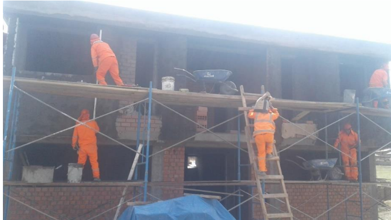
Anexo 16: Se denota el proceso tarrajeo en la parte frontal con el espesor de 1.5cm de acuerdo a la norma técnica peruana.
