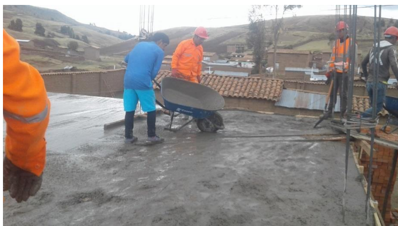
Anexo 09: Se denota el vaciado de concreto en la losa aligerada del primer nivel, con un espesor de 5cm y con el diseño f'c=210\text{kg/cm}^2 .
