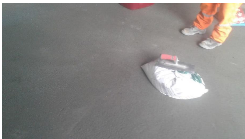
Figura 9: Vista del Contrapiso.
