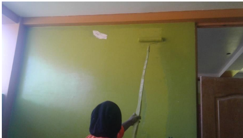
Anexo 20: Se denota la aplicación de pintura en las partes interiores a dos manos.
