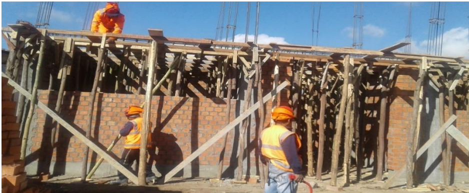
Figura 16: Habilitación de Pies Derechos en el primer nivel.
