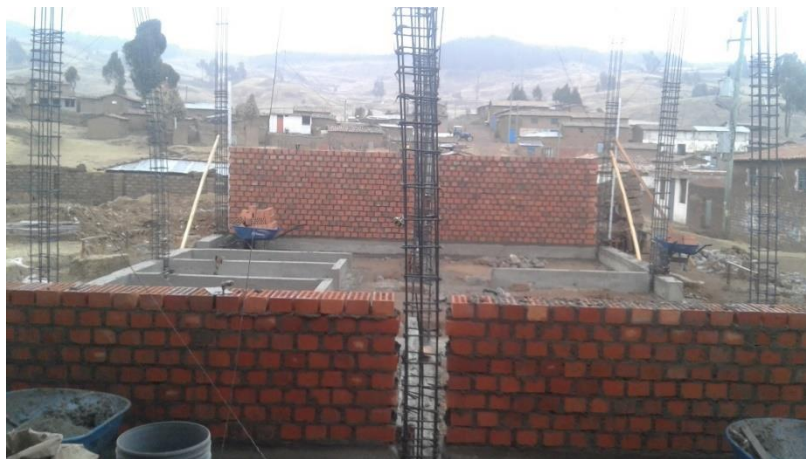
Anexo 05: En la imagen se denota, el asentado de ladrillos para muros exteriores de 25cm de espesor.
