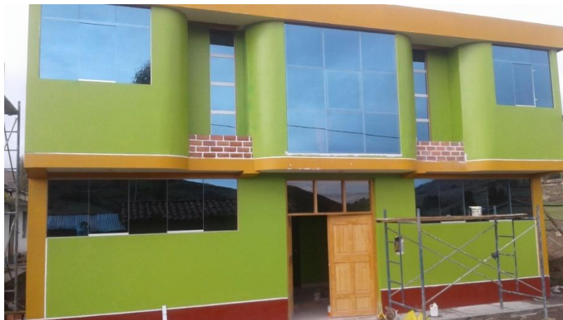
Anexo 23: Vista panorámica culminada parte frontal.
