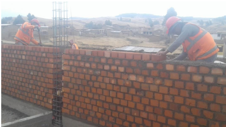
Figura 21: Proceso de asentado en muros.
