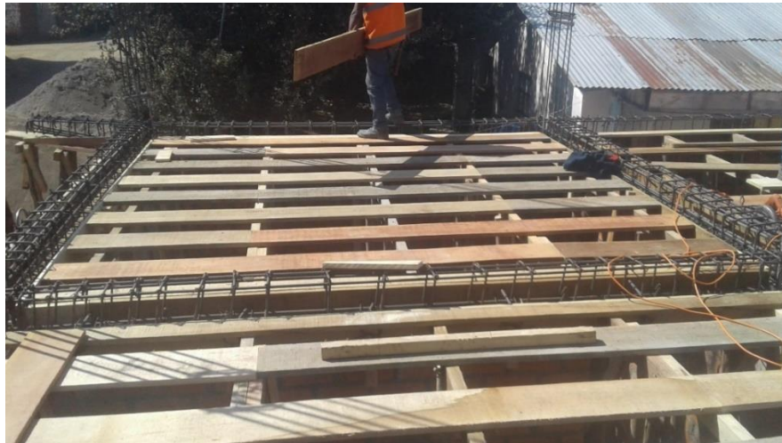
Figura 17: Encofrado de Losas.
