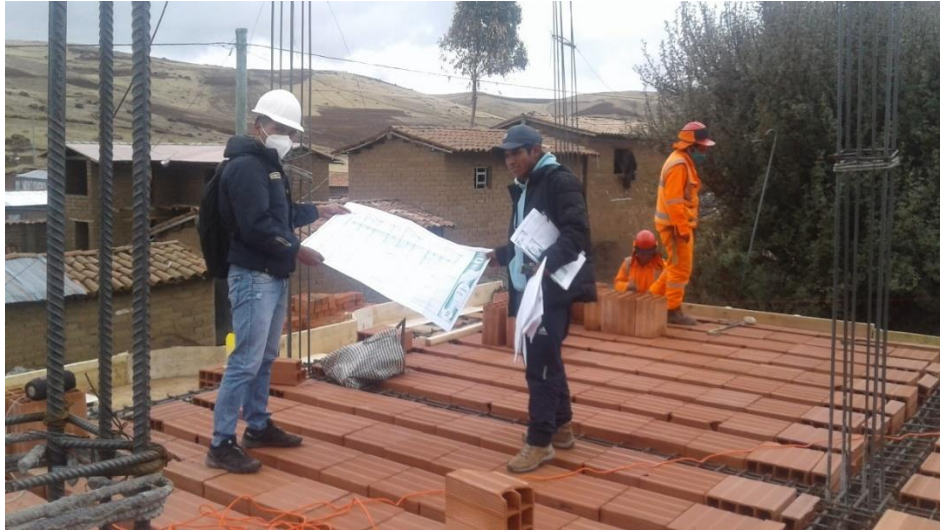
Figura 18: Colocación de Ladrillos en cada nivel
