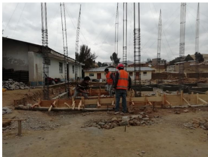
Figura 7: vista de vaciado concreto para sobrecimientos.
