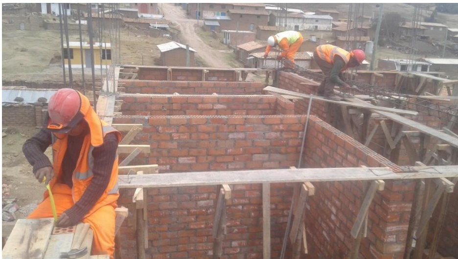
Figura 13: Habilidad para las vigas y losas
