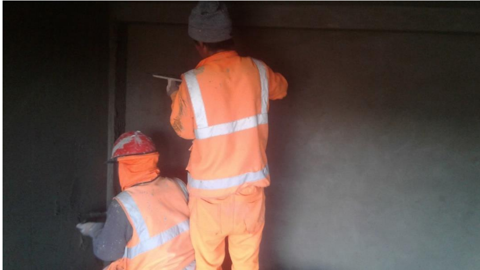
Figura 22. Tarrajeo en vigas, columnas y muros.
