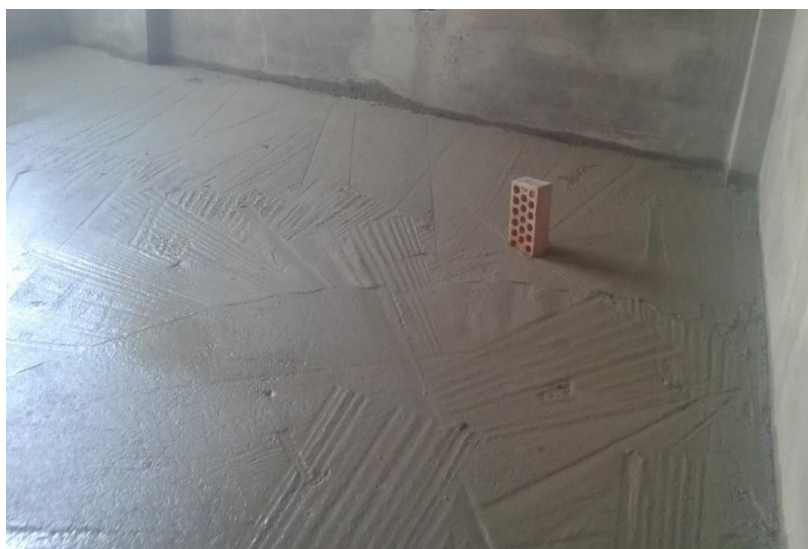
Figura 8: Vista de falso piso.
