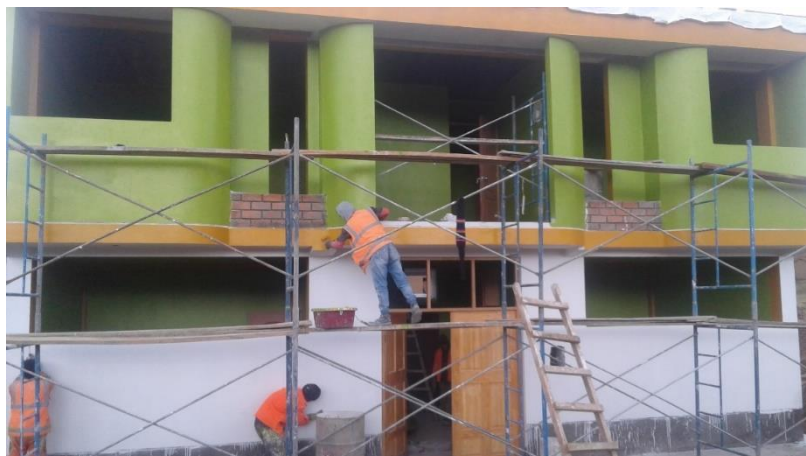
Anexo 21: Se denota la aplicación de pintura en las partes exteriores a dos manos.
