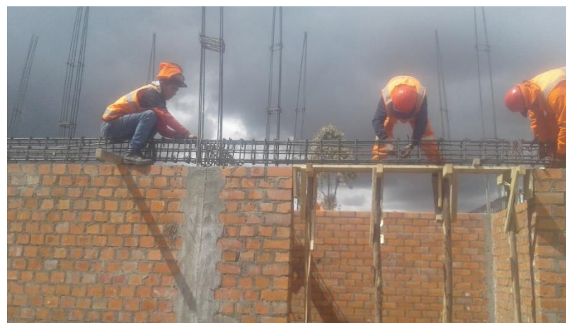
Anexo 06: En la imagen se denota, la preparación de la armadura de aceros para vigas del primer nivel.
