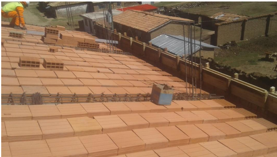
Figura 14: Encofrado de viga canal
