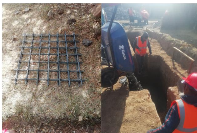
Figura 10: Armado, y Vaciado de Concreto en Zapatas
