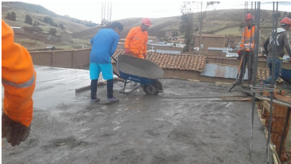
Figura 19: Vaciado de concreto en losas.
