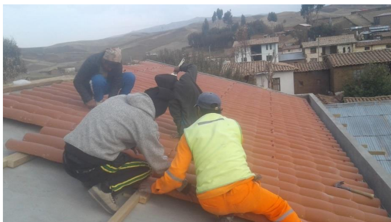
Anexo 15: Se denota la colocación de las tejas andinas de fibrocemento.
