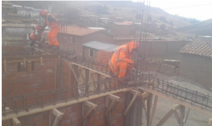
Figura 12: Armado de vigas.
