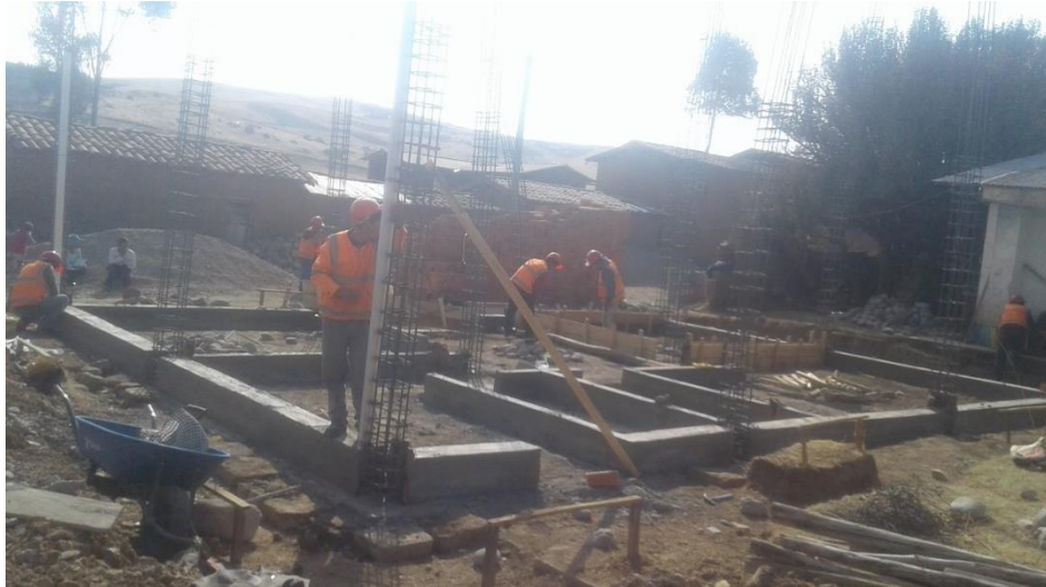
Figura 20: Obtención de Niveles, para los muros portantes
