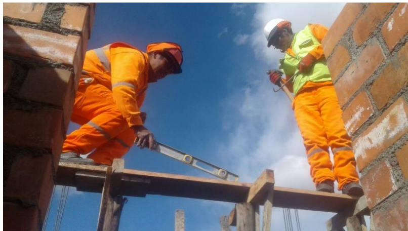
Anexo 11: Se denota el fondeo y nivelación para vigas del segundo nivel.
