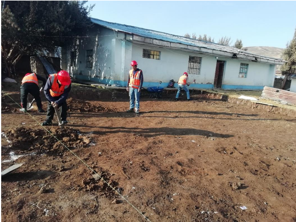
Anexo 03: Se denota el trabajo de la nivelación del terreno, según el área requerida del expediente técnico
