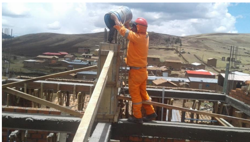
Anexo 12: Se denota el vaciado de concreto en columnas de 1.30m de altura.
