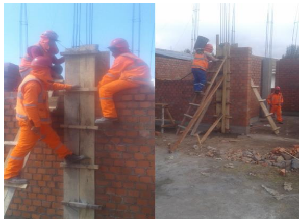
Figura 11: Encofrado y vaciado de concreto en columna
