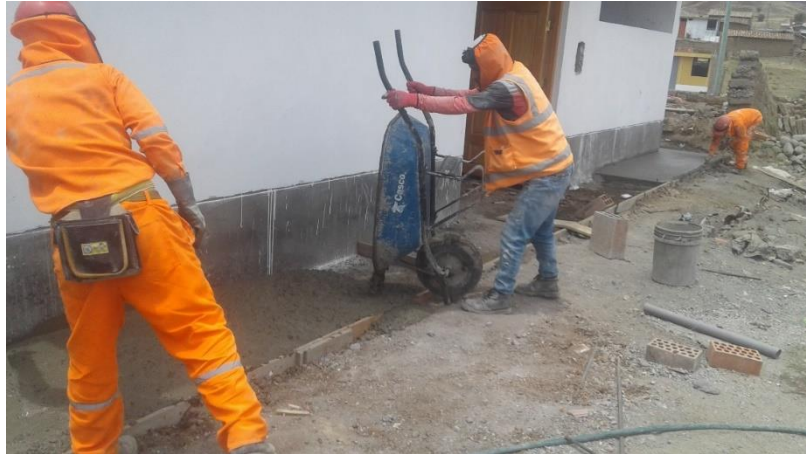
Anexo 19: Se denota el vaciado de concreto en las veredas.
