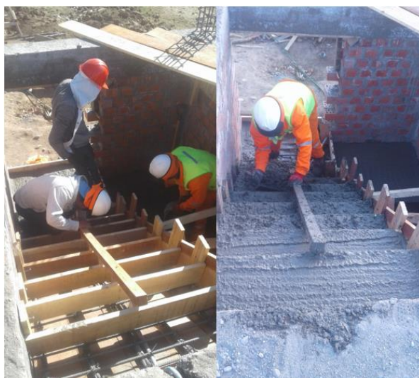
Figura 15: Habilitación y vaciado de concreto en Escaleras.
