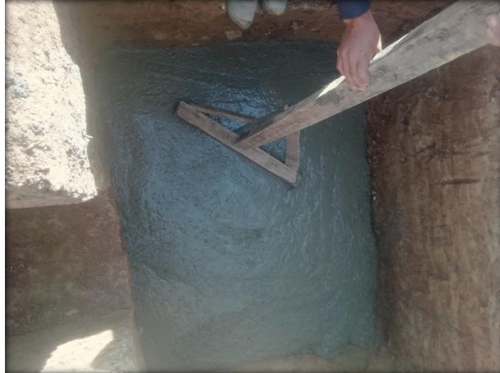
Figura 4: vaciado de solado y nivelado
