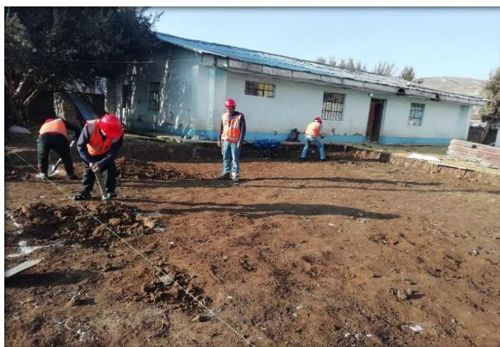
Figura 3: Nivelación del Terreno.
