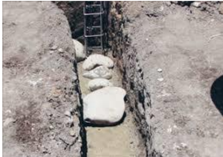
Figura 5: Vista del vaciado para cimientos corridos.
