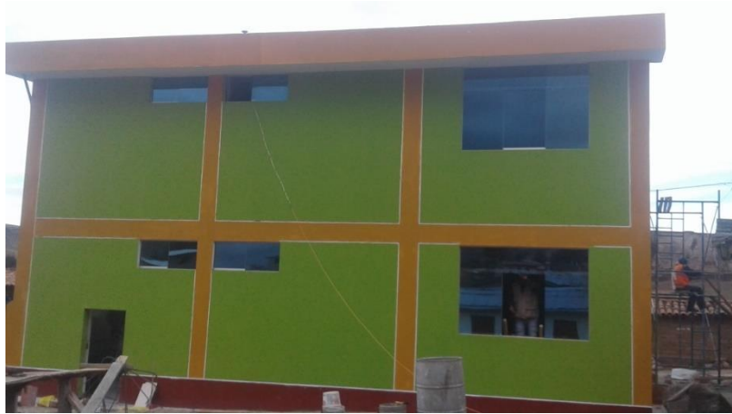
Anexo 22: Vista panorámica culminada parte posterior.
