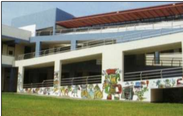
Figura 26: Rampa peatonal y patio central
