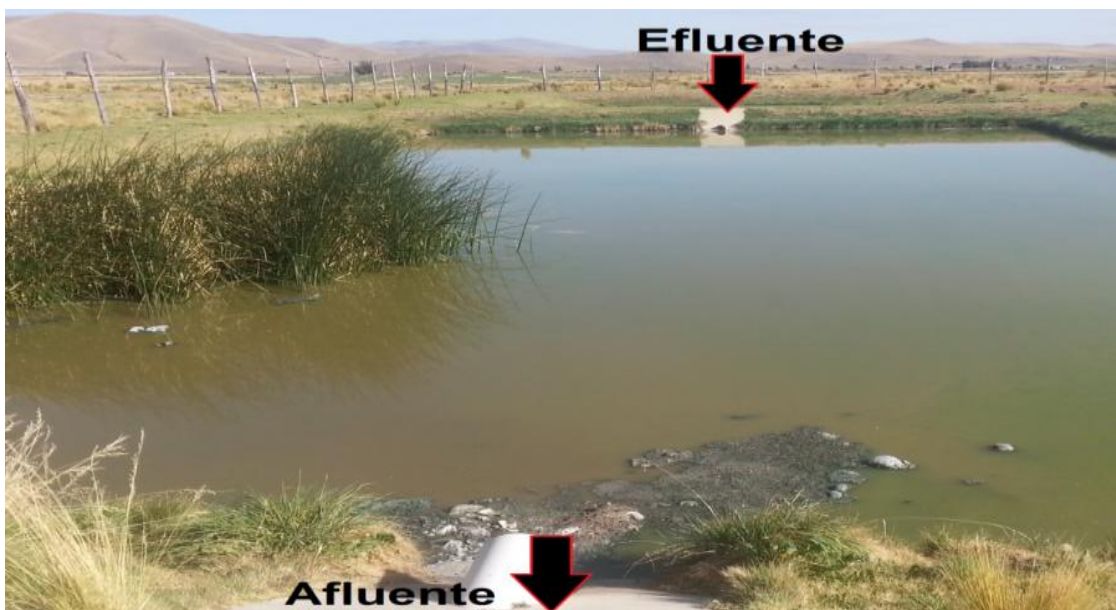
Figura 1.2 Tratamiento del agua residual en lagunas facultativas, Mañazo.
