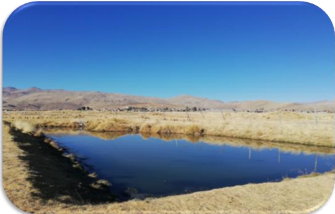
FOTOGRAFÍA 01: Se observa la laguna facultativa 1 de la localidad de Mañazo
