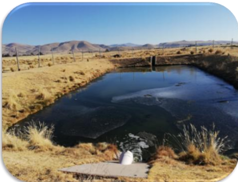
FOTOGRAFÍA 02: Se observa la laguna facultativa 2 de la localidad de Mañazo
