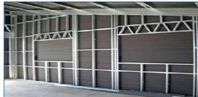
El Centro de Rehabilitación posee en sus fachadas placas de yeso sobre un marco de Metsec, lo que proporciona la colocación de la tabiquería y los paneles de cristales.
