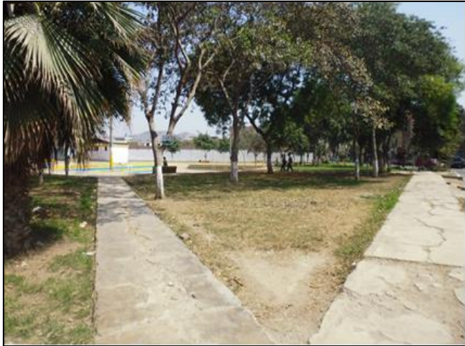
Figura 37. Imagen del estado de las circulaciones peatonales.
