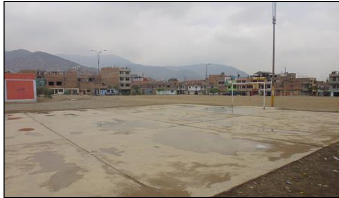
Figura 21. Imagen de la losa existente.
