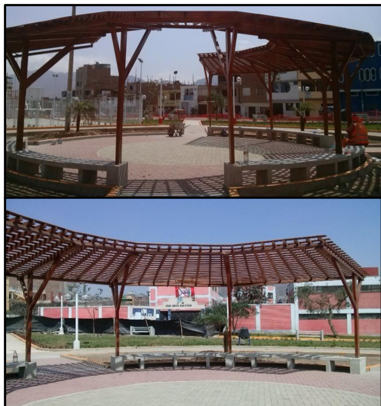
Figura 63. Vista de la zona 1 (pérgola)
