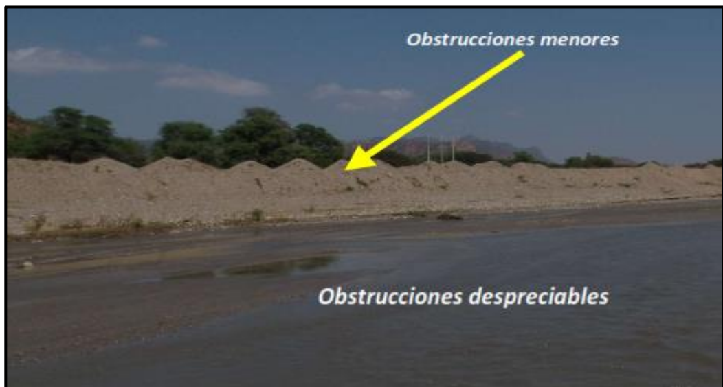
Figura 9. Tramo del río con obstrucciones menores y despreciables
