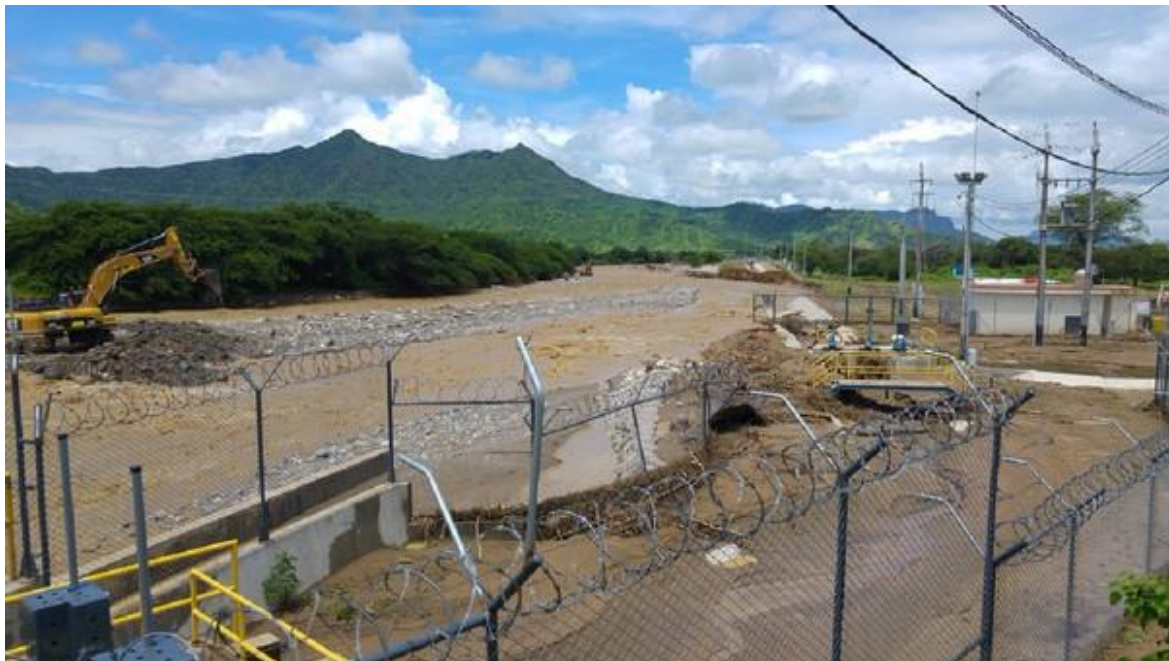
Figura 36. Bocatomía La Juliana después de padecer el paso de un caudal mayor a 703 m 3 /s (Fuente: RPP / noticias)
